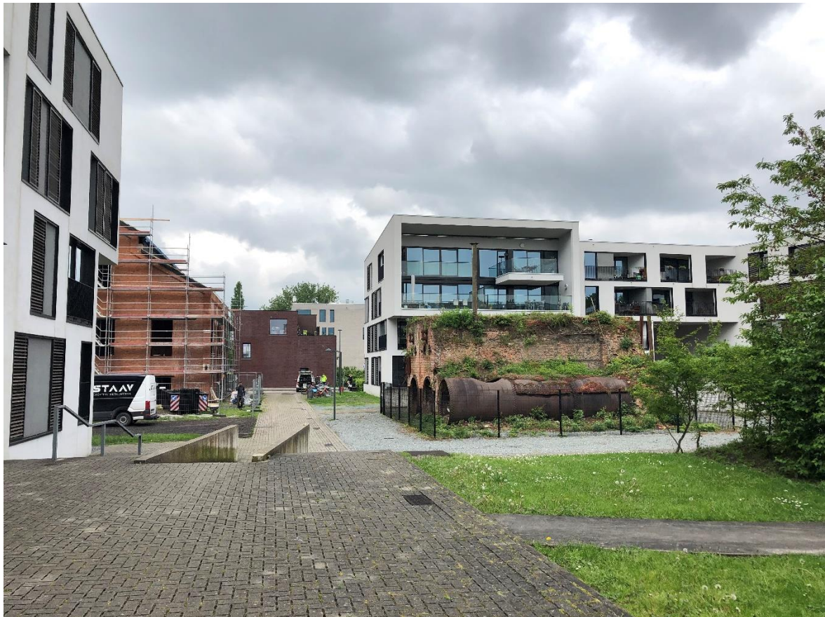
Foto 6 – Zicht (vanuit het zuiden) op het machinehuis en het ketelhuis van de site Alsberge-Van Oost (© Onroerend Erfgoed – Leen Meganck).
