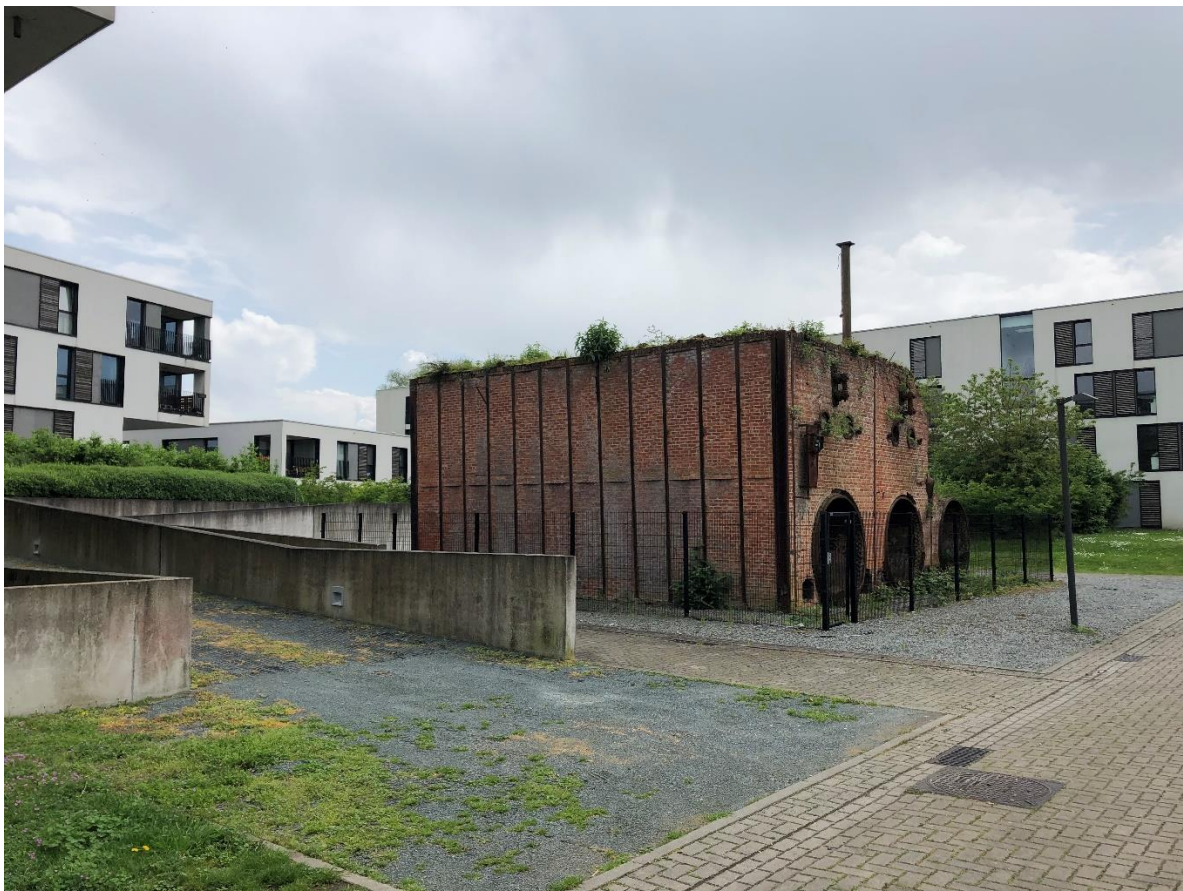
Foto 5 – Zicht (vanuit het noorden) op het ketelhuis en onmiddellijke omgeving van de site Alsberge-Van Oost (© Onroerend Erfgoed – Leen Meganck).
