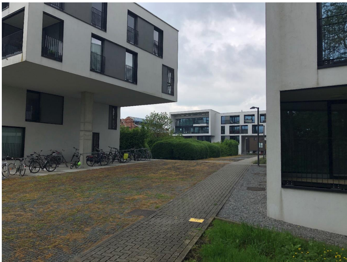
Foto 9 – Zicht (vanuit het zuidoosten) op de appartementsgebouwen in de omgeving van het machinehuis en het ketelhuis van de site Alsberge-Van Oost (© Onroerend Erfgoed – Leen Meganck).
