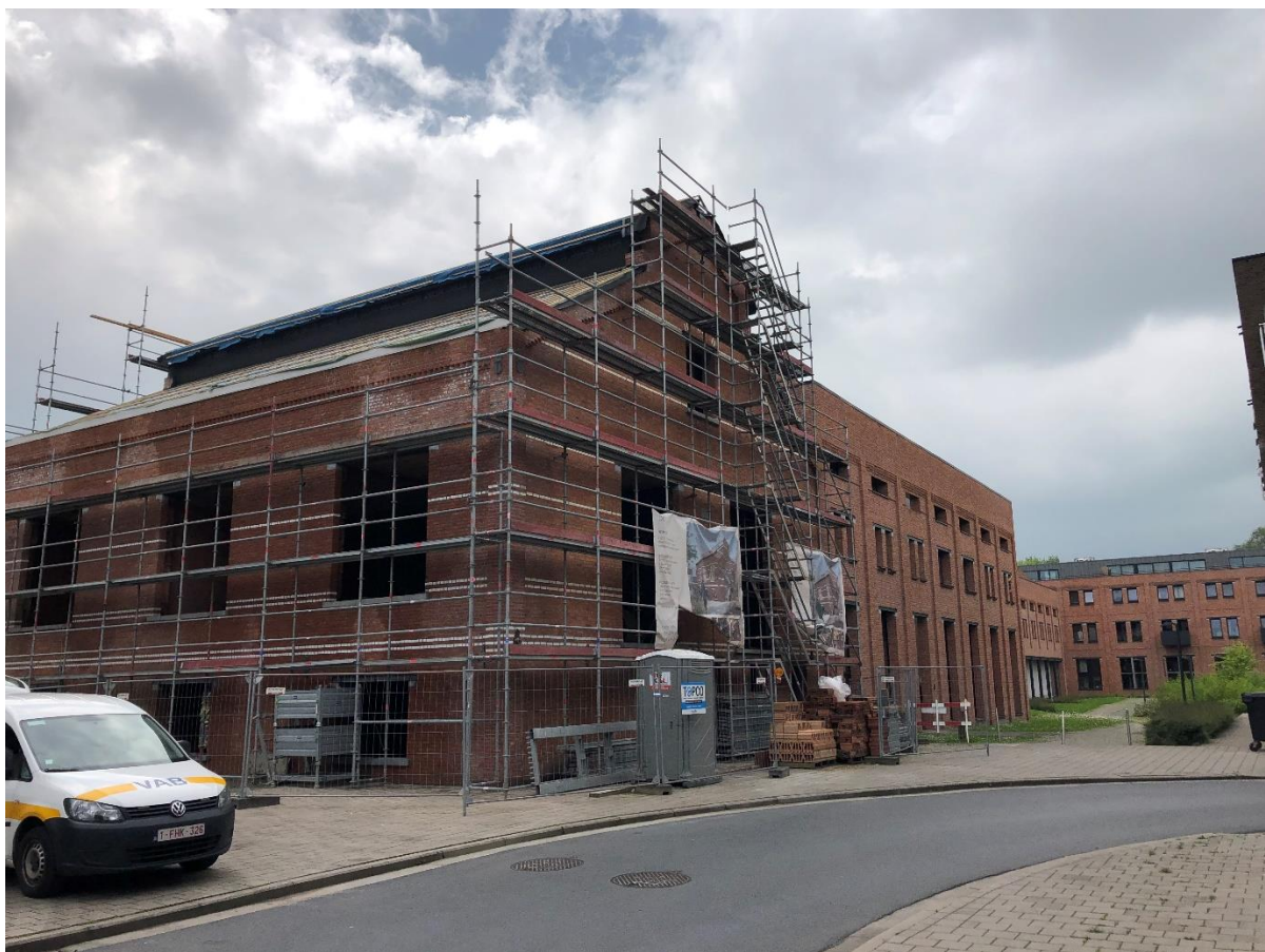
Foto 4 – Zicht op het machinehuis van de site Alsberge-Van Oost (© Onroerend Erfgoed – Leen Meganck).
