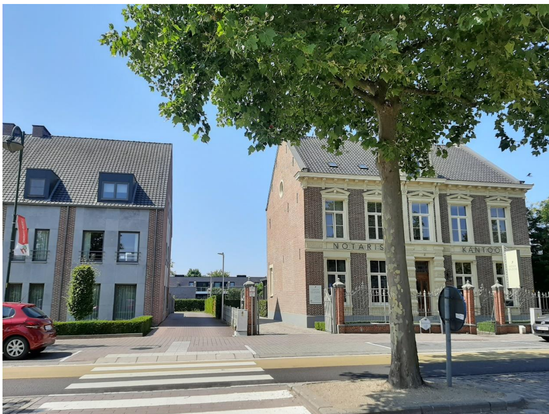
Foto 1. Huis Simons rechts en appartementsgebouw links
