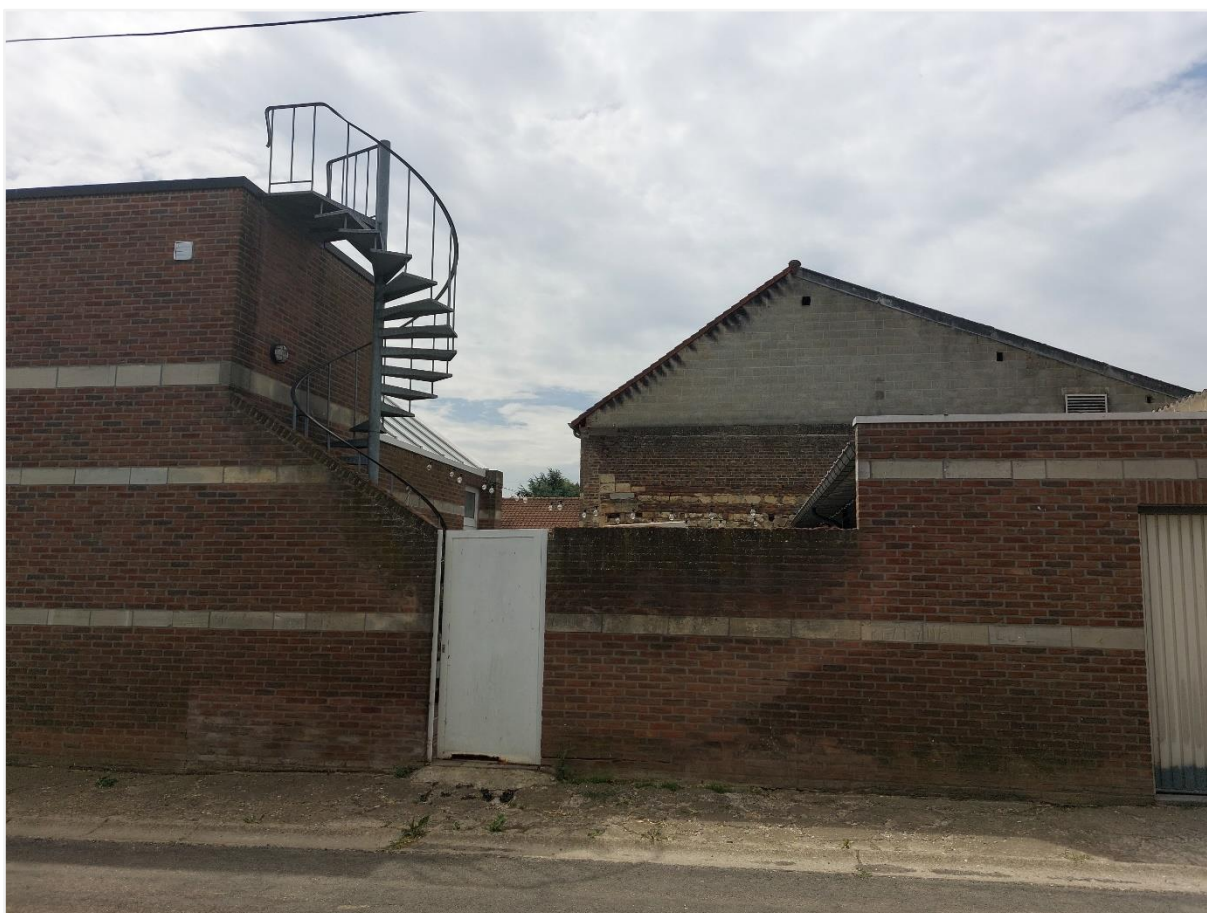
Foto 6: Hof de Méan omgeving – De Meanstraat zonder nummer – zicht op de straatmuur en de topgevel van de daarachterliggende heropgebouwde schuur-loods (gelegen binnen het op te heffen dorpsgezicht).
