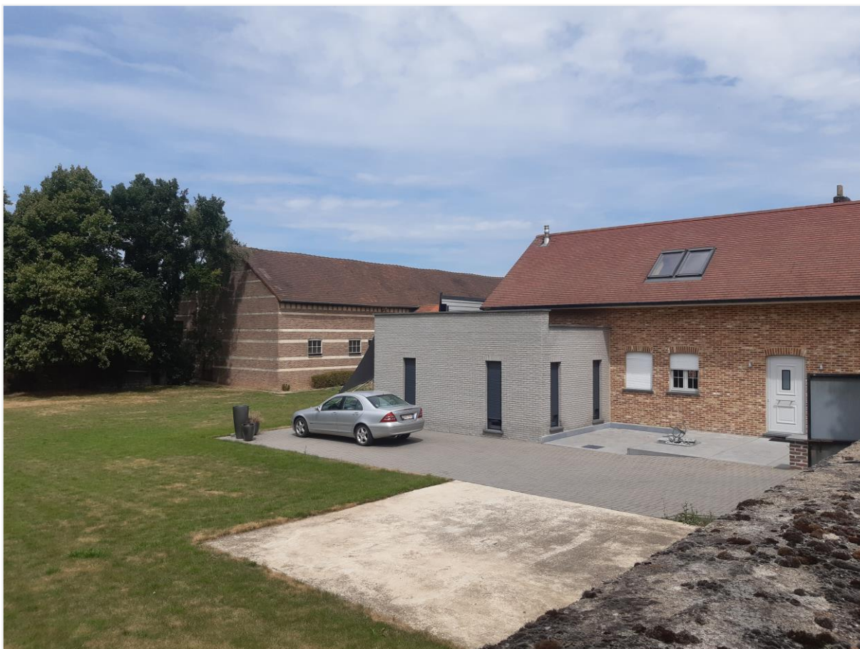
Foto 8: Omgeving van het Hof de Méan, Bolderstraat 60-62 – zicht op de herbouwde vroegere schuur, de tot woonhuis verbouwde vroegere remise en tuin (gelegen binnen het op te heffen dorpsgezicht).
