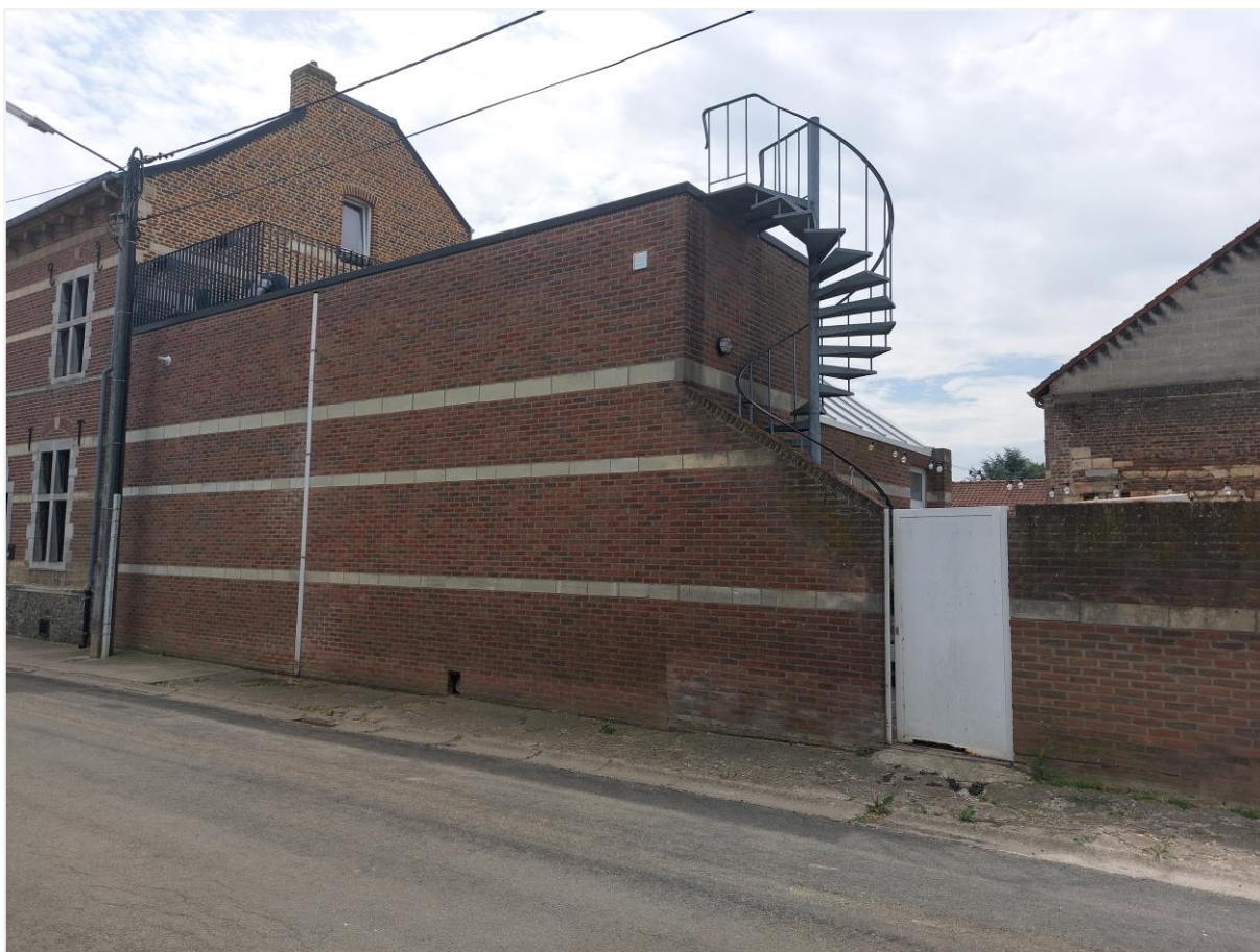
Foto 5: Hof de Méan omgeving – De Meanstraat 2A– zicht op straatgevels herenhuis (monument) en straatmuur met topgevel van heropgebouwde schuur-loods (gelegen binnen het op te heffen dorpsgezicht).
