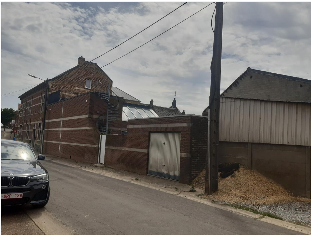
Foto 7: Hof de Méan omgeving – De Meanstraat 2A en zonder nummer – zicht op het herenhuis de Méan (monument) en de straatmuur en de daarachterliggende heropgebouwde schuur-loods (gelegen binnen het op te heffen dorpsgezicht).
