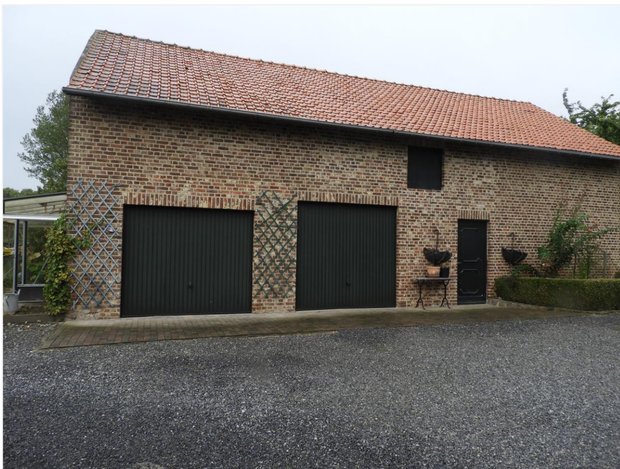
Foto 14: Verbouwde schuur van 1913 met nieuwe muuropeningen en vernieuwde draagstructuur in beton (© Onroerend Erfgoed 26 september 2022).
