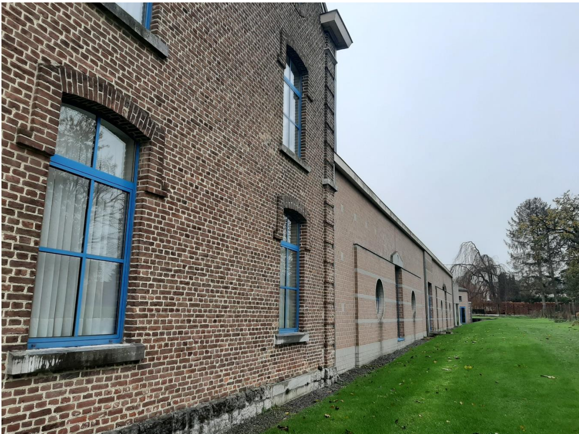
Foto 4: zijgevel van het klooster en schoolgebouw
