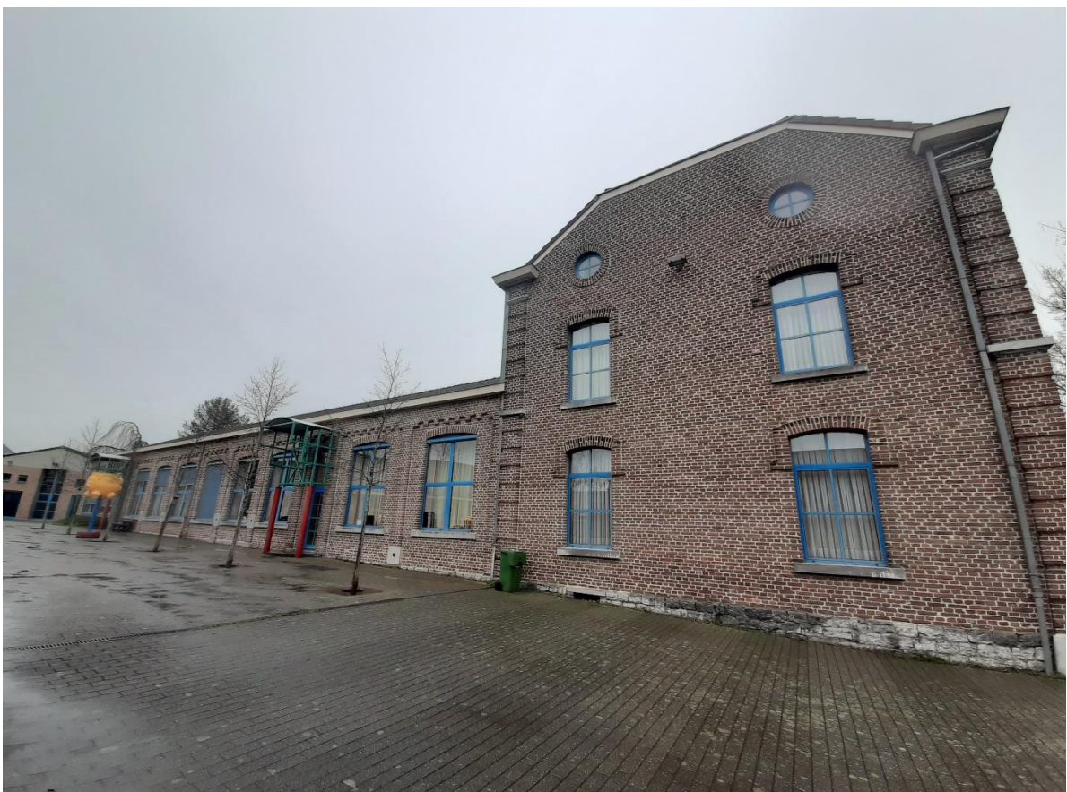
Foto 2: zijgevel van het klooster en schoolgebouw
