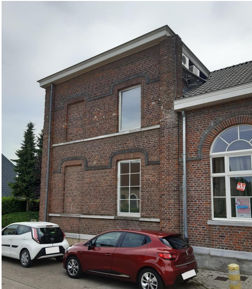
Foto 3: zijgevel van het voormalig gemeentehuis
