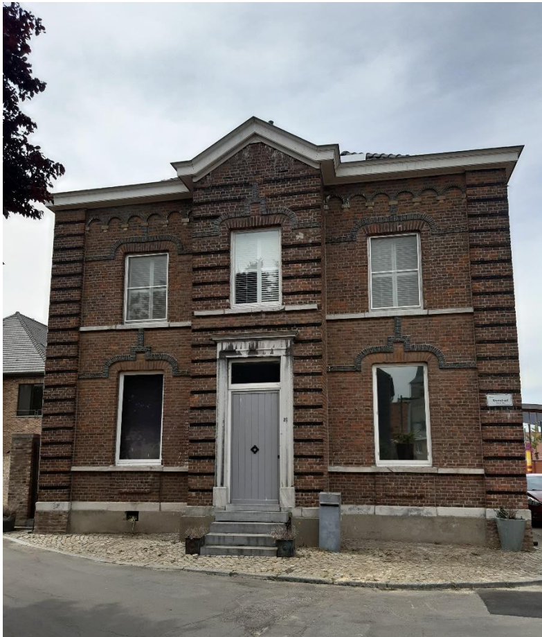
Foto 1: voorgevel van het voormalig gemeentehuis
