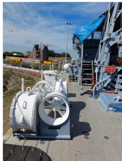
Foto 11: bakboordzijde met verankerd veegtuig en de toegangstrap naar de brug
