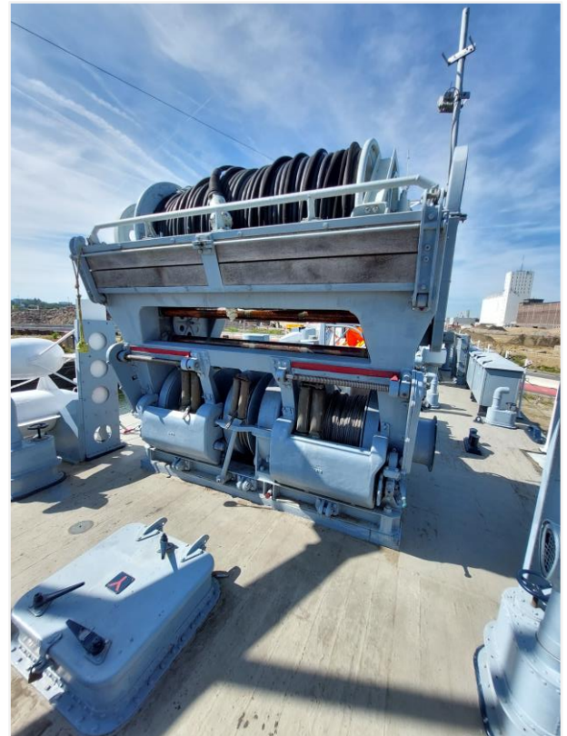
Foto 19: lier met stroomkabel voor magnetische mijnbestrijding en staalkabels voor bestrijding contactmijnen
