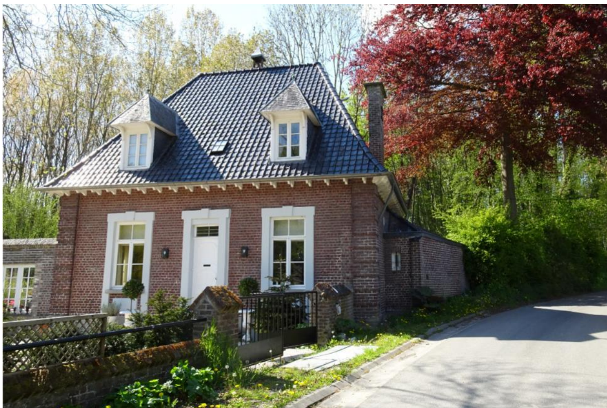
Foto 56: Conciërgewoning ter hoogte van Kasteelstraat (voor- en zijgevel).
