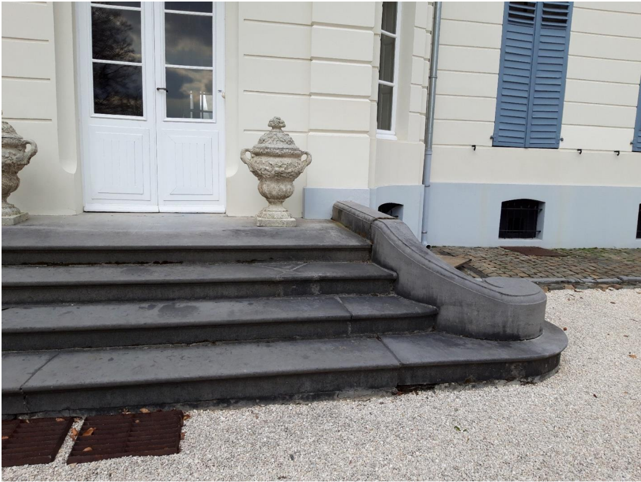
Foto 7: Kasteel – hoger opgaand middenrisaliet – inkompartij met bordestrap met afgeronde hoeken.
