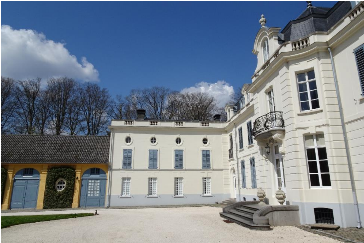
Foto 17: Westelijke zijvleugel van tweeënhalve bouwlaag (voorzijde) met rechts kasteel en links lagere westelijke aanhorigheid.
