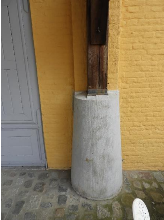
Foto 33: Westelijke aanhorigheid (achtergevel aan dienstert) – halfkegelvormige sokkel als basis voor houten dakoverstek.
