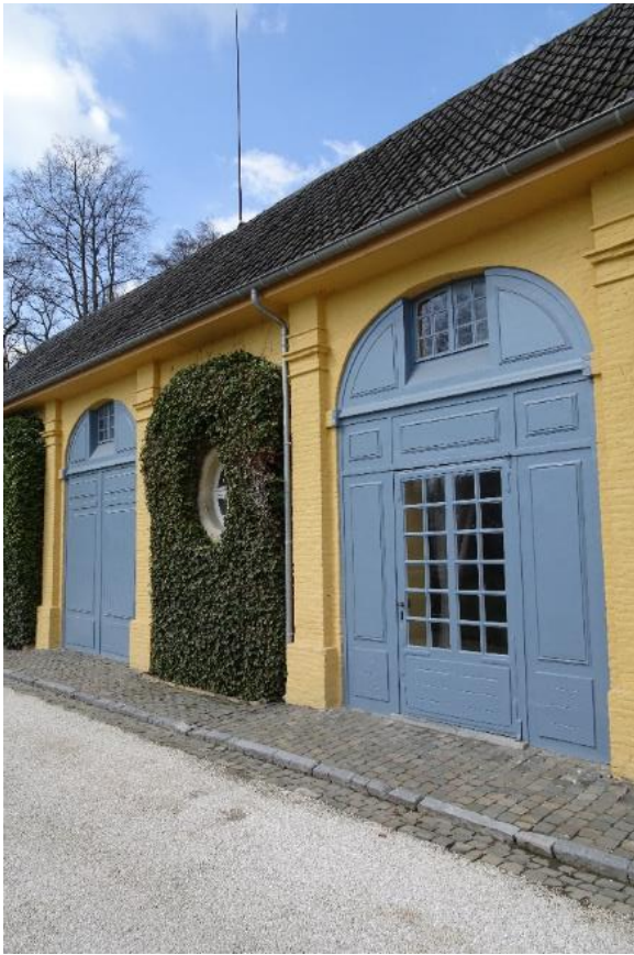
Foto 30: Westelijke aanhorigheid (voorzijde) detail metselwerk met lisenen – poort.
