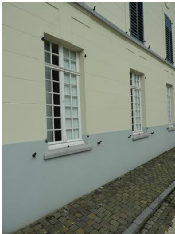
Foto 22: Oostelijke zijvleugel (voorzijde) - detail gevelparament en schrijnwerk.
