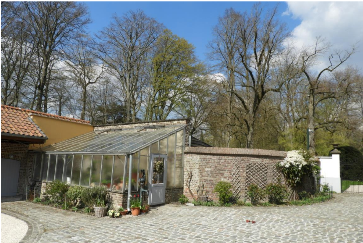
Foto 43: Westelijk dienststerf – rechthoekige muurserre en afbuigende afsluitmuur – afsluitpoort aan bakstenen pijlers.
