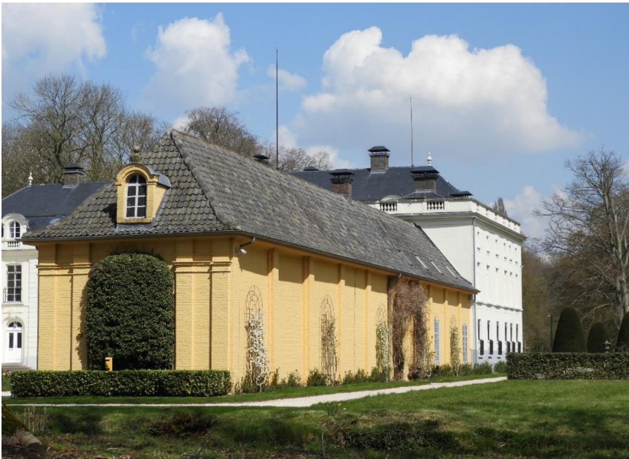
Foto 27: Oostelijke aanhorigheid (kopgevel en achtergevel) – aansluiting met oostelijke zijvleugel.
