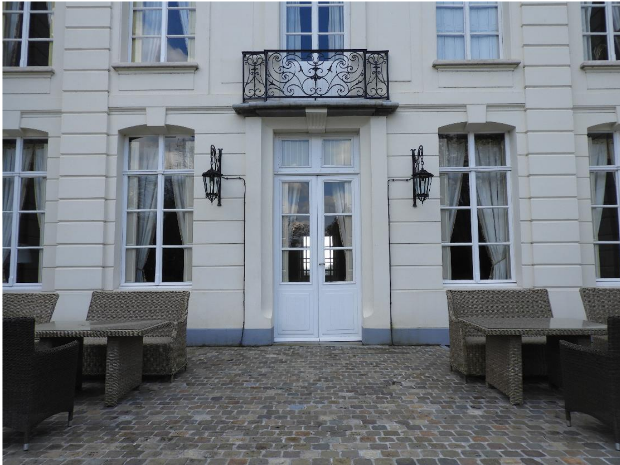
Foto 14: Kasteel – verdiept middendeel van vijf traveeën met voorliggend afgerond terras.
