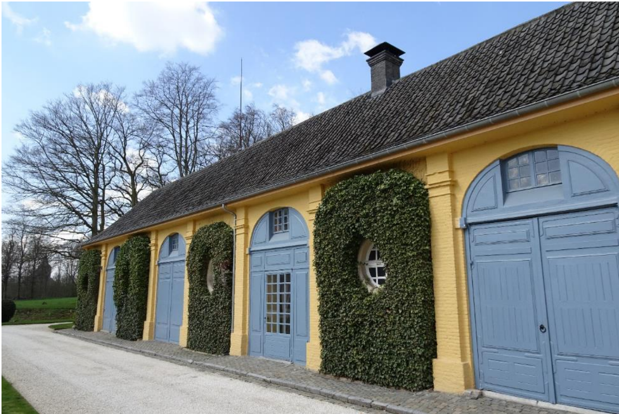
Foto 28: Westelijke aanhorigheid (voorzijde) van tien traveeën georiënteerd naar de straat en toegangsdreef.
