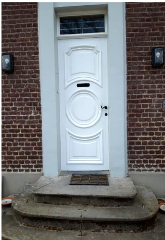
Foto 54: Conciërgewoning - voordeur aan bordes.
