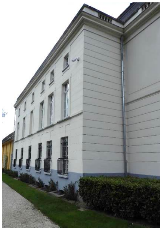
Foto 23: Oostelijke zijvleugel (achtergevel).
