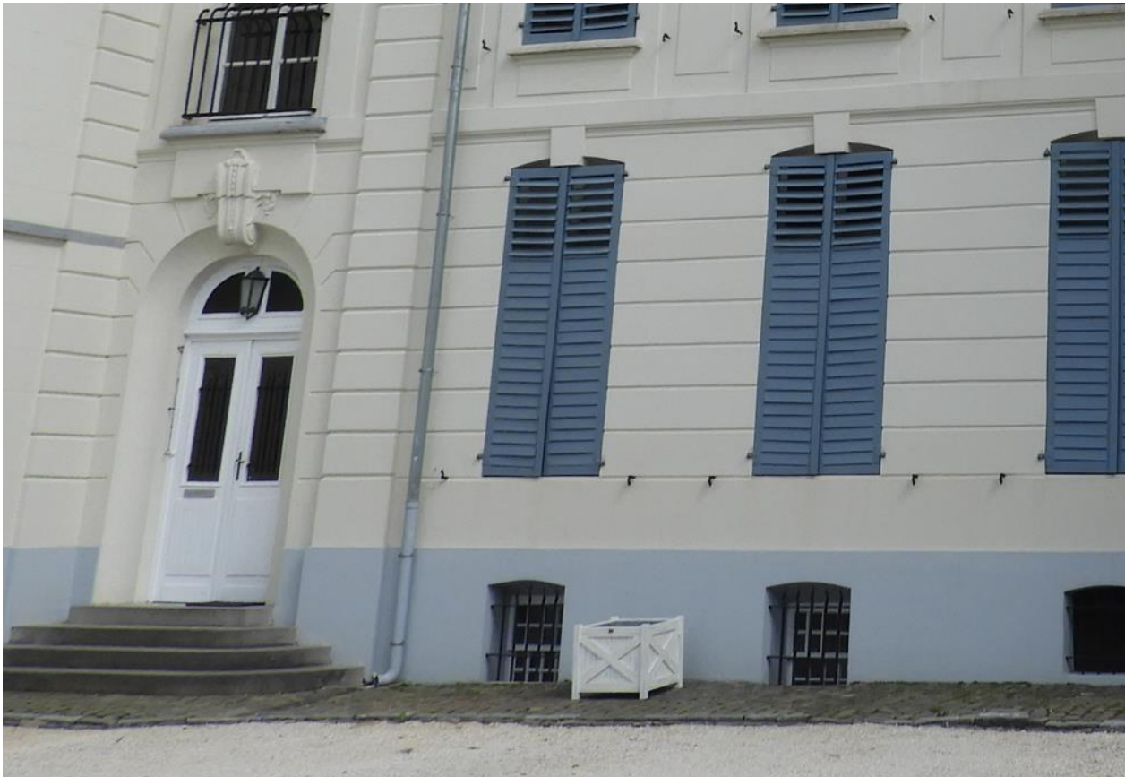
Foto 8: Kasteel – detail gevelafwerking met bossage – zicht op westelijke toegang nabij westelijke zijvleugel.
