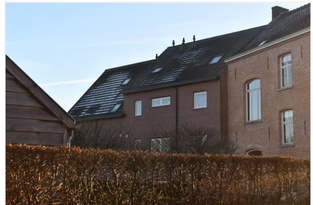
Foto 4: Buggenhout, Lijneveldstraat 5 en 7, tuinzijde (copyright Onroerend Erfgoed)
