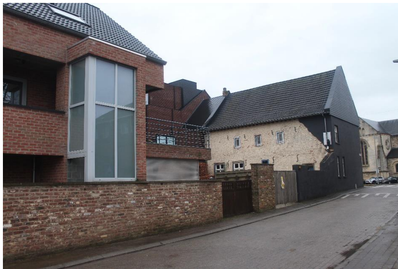
Foto 5: zicht in de Omstraat vanuit het westen op de achtergevel en de tuinmuur van het monument en op een deel van de recente bebouwing in de voormalige tuin van het monument
