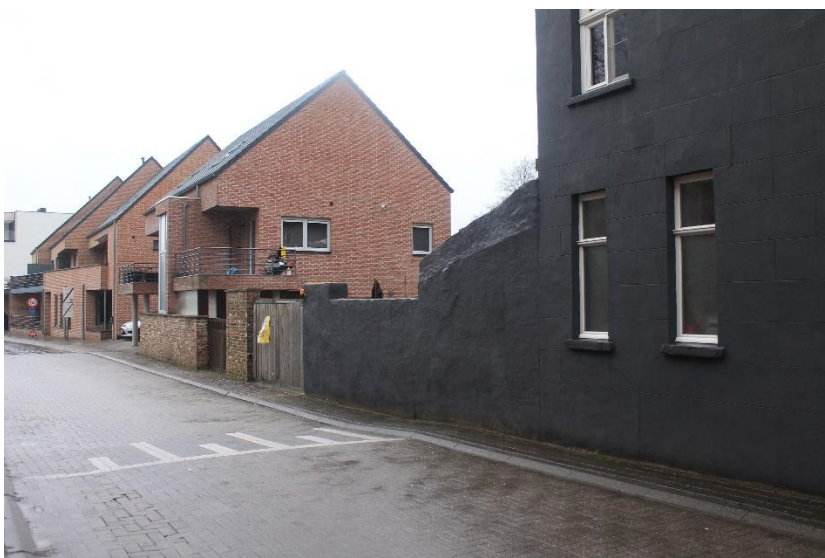
Foto 3: zicht in de Omstraat vanuit het zuidoosten op de zijgevel en tuinmuur van het monument en op de recente bebouwing in de voormalige tuin van het monument
