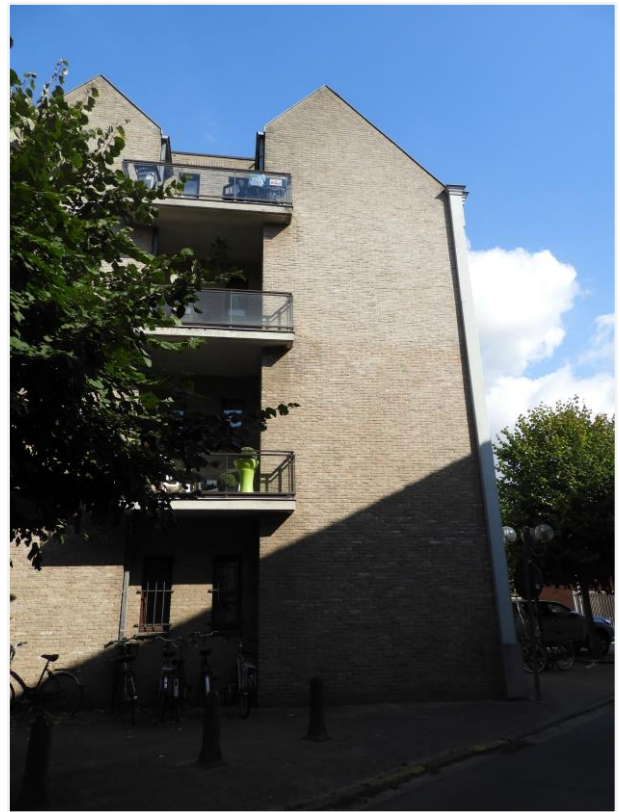
Foto 2: nieuwbouw achter de heropgebouwde voorgevel
