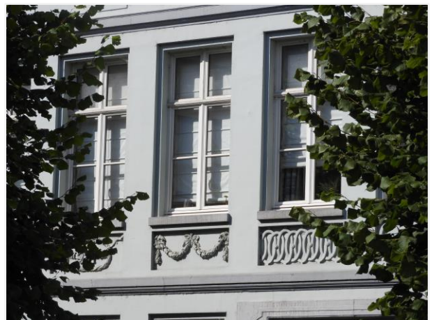
Foto 4: vernieuwd schrijnwerk met schrijnwerk naar historisch uitzicht.
