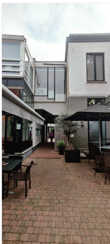
Foto 7: achtergevel met poortdoorgang en traphal erboven
