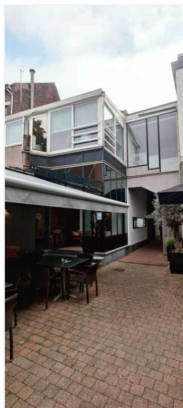
Foto 8: achtergevel met moderne aanbouw
