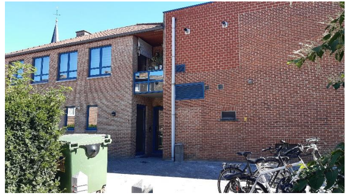
Foto 8: Nieuwe gildezaal en appartementen (zijde Diepstraat) (5 september 2023)
