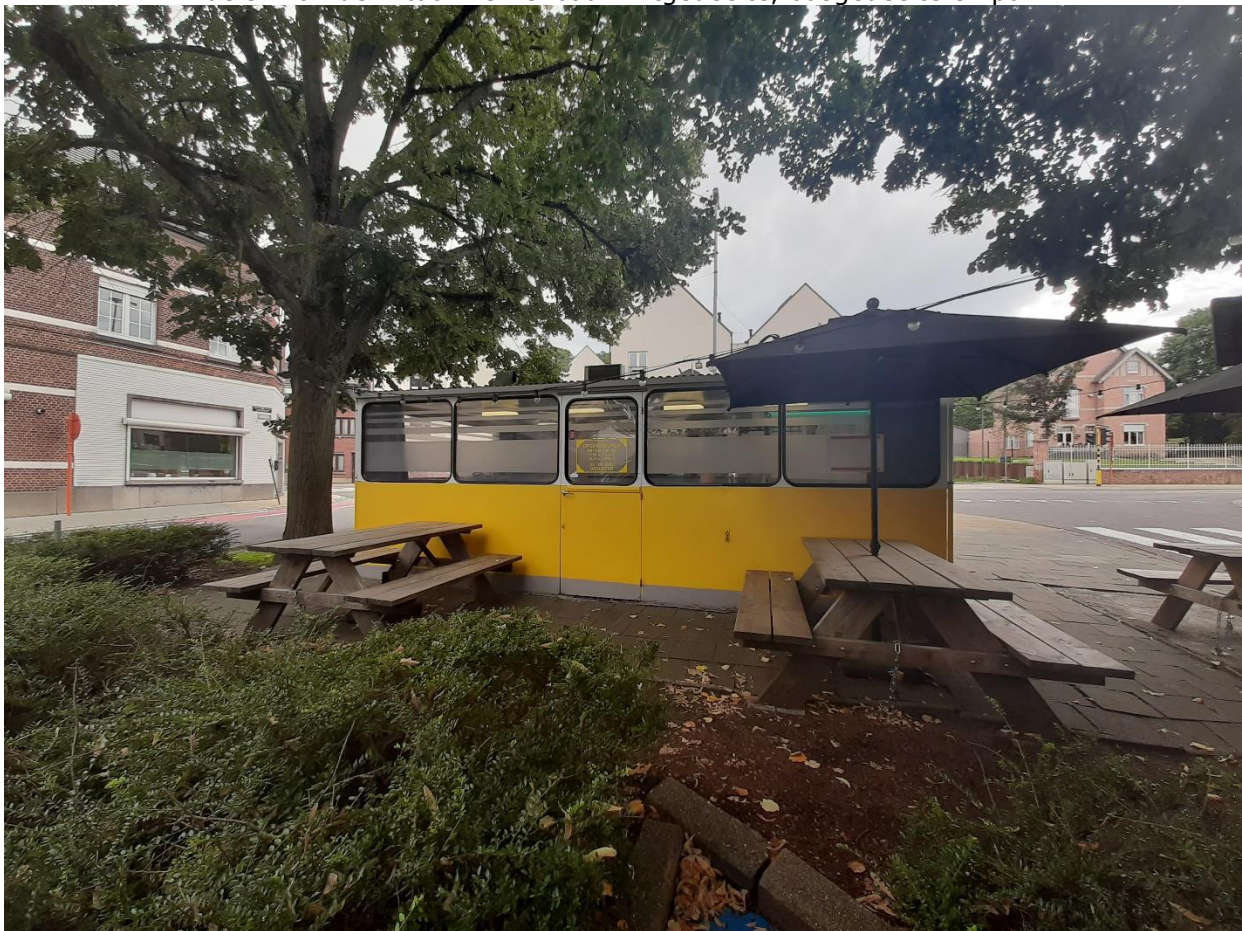
Foto 4: Noordgevel van het zitgedeelte van het frietkot aan de Albertlaan.
