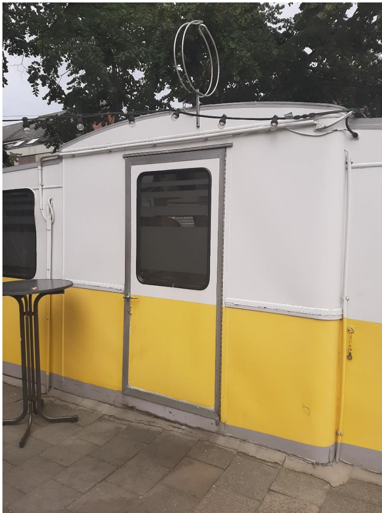
Foto 7: Busgedeelte van het frietkot aan de Albertlaan.
