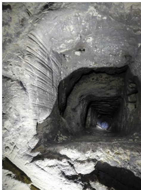
Foto 27. Schacht (foto van in de groeve naar boven) met ingesleten touwsporen
