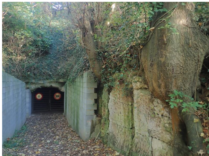
Foto 44. Toegang Lacroixberg met rechts mergel met kasporen en dicht bij de ingang de betonstenen die de toegang moeten versterken (knelpunt)
