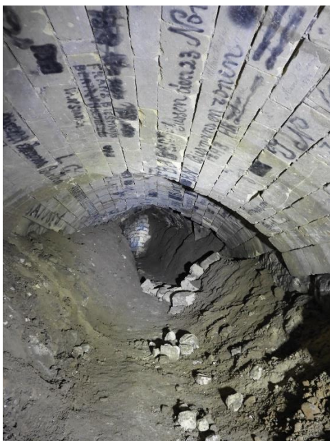
Foto 28. Toegangstunnel Stadtberg I
