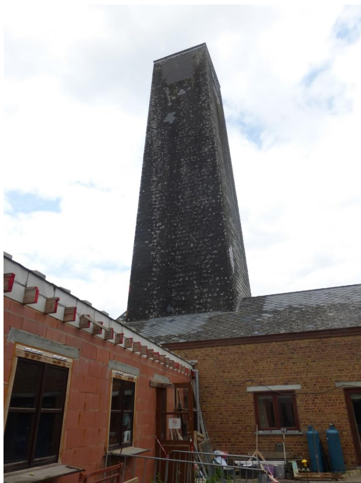
Foto 6: de schutterstoren op vierkante plattegrond is ingebouwd in het éénlaagse bakstenen volume onder zadeldak van het vroegere gildelokaal (niet in de bescherming opgenomen). Haaks aansluitend bij het vroegere gildelokaal is het nieuwe lokaal in aanbouw (niet in de bescherming opgenomen) (plaatsbezoek Onroerend Erfgoed 26.07.2023).
