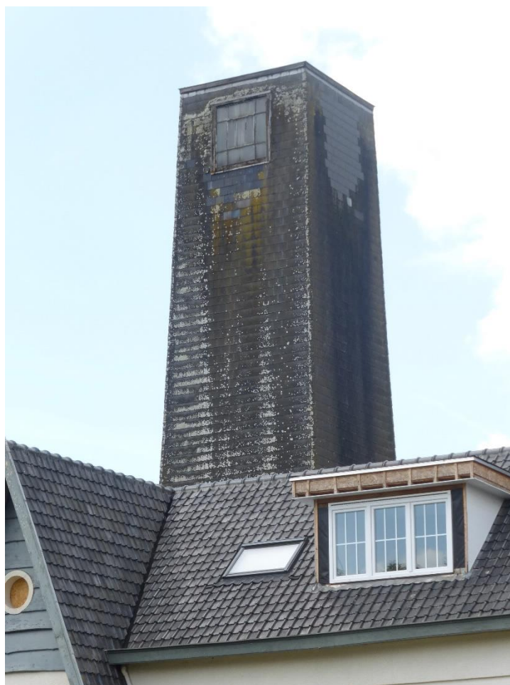
Foto 4: zicht op de schutterstoren vanuit het oosten. Het raam met venster in de oostzijde van de top is bewaard. Het dichtgemaakte raam in de noordzijde van de top is nog afleesbaar aan de minder verkleurde leien (plaatsbezoek Onroerend Erfgoed 26.07.2023).
