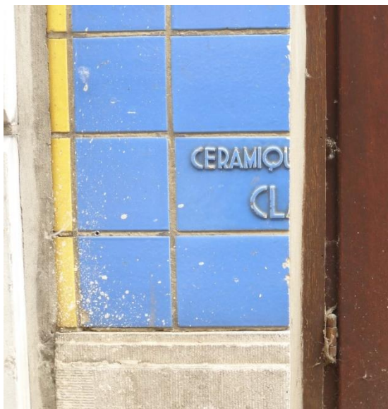
Foto 13-14: blijkt een signatuurtegel, links boven de plint, zijn de tegels geplaatst door het Brusselse Huis Claes, importeur van Tsjecho-Slovaakse tegels. Rechts: de afgeronde hoeken van het portaal zijn verrijkt met smalle, decoratieve lichtarmaturen met smeedijzeren traliewerk in spiraalvorm. De vensterbanken van de brede vensters zijn uitgewerkt in gele profieltegels (13: plaatsbezoek Onroerend Erfgoed 16.05.2022 - 14: rapport Monumentenwacht, Wim Meers, plaatsbezoek 30.01.2023, © Monumentenwacht).
