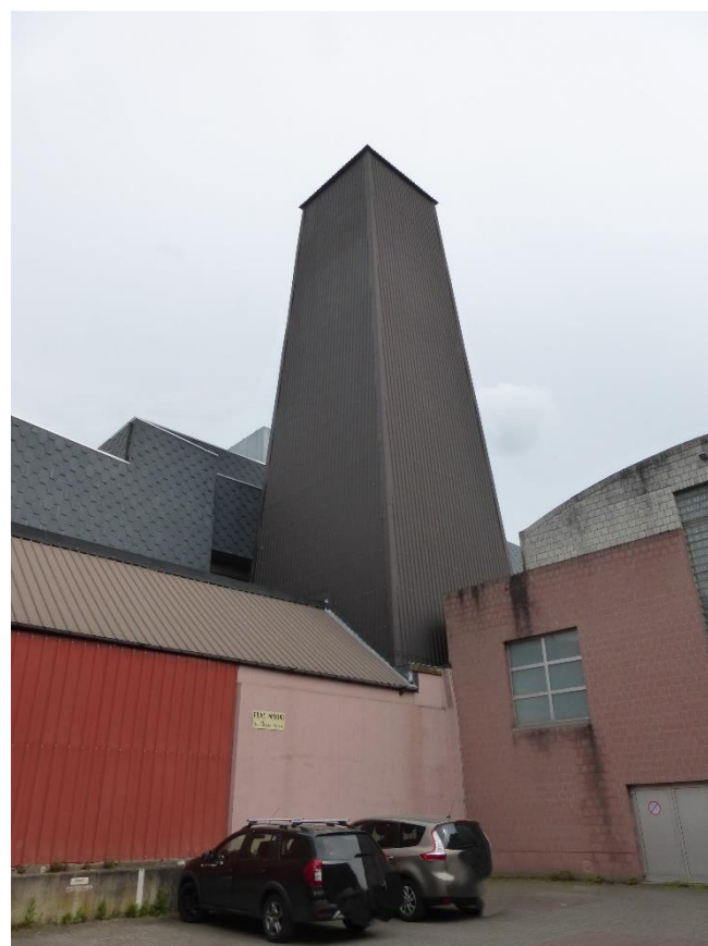
Foto 4: zicht op de obeliskvormige schutterstoren vanaf de ten westen aan de gelagzaal palende parkeerplaats (plaatsbezoek Onroerend Erfgoed 16.05.2022).
