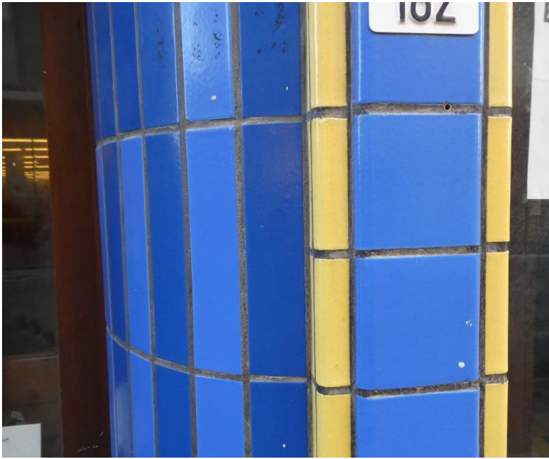
Foto 16-17: de pui van de voormalige herberg "In de Toewip". Links: detail profieltegels bij portaal. Rechts: detail profieltegels bij druiplijst tussen de ramen en de bovenlichten (rapport Monumentenwacht, Wim Meers, plaatsbezoek 30.01.2023, © Monumentenwacht).
