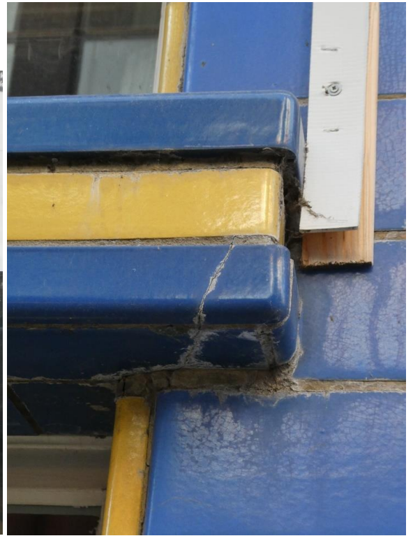
Foto 16-17: de pui van de voormalige herberg "In de Toewip". Links: detail profieltegels bij portaal. Rechts: detail profieltegels bij druiplijst tussen de ramen en de bovenlichten (rapport Monumentenwacht, Wim Meers, plaatsbezoek 30.01.2023, © Monumentenwacht).
