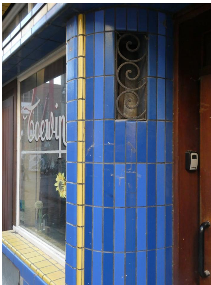
Foto 13-14: blijkt een signatuurtegel, links boven de plint, zijn de tegels geplaatst door het Brusselse Huis Claes, importeur van Tsjecho-Slovaakse tegels. Rechts: de afgeronde hoeken van het portaal zijn verrijkt met smalle, decoratieve lichtarmaturen met smeedijzeren traliewerk in spiraalvorm. De vensterbanken van de brede vensters zijn uitgewerkt in gele profieltegels (13: plaatsbezoek Onroerend Erfgoed 16.05.2022 - 14: rapport Monumentenwacht, Wim Meers, plaatsbezoek 30.01.2023, © Monumentenwacht).
