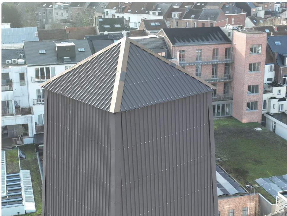
Foto 9: de toren versmalt naar boven toe en is afgedekt met een zwak hellend, licht overkragend piramidedak (rapport Monumentenwacht, dronebeeld Wim Meers, plaatsbezoek 30.01.2023, © Monumentenwacht).
