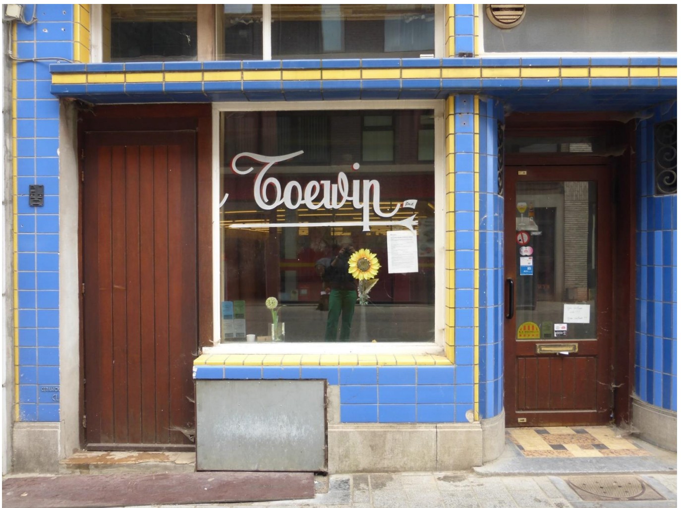
Foto 12: de brede ramen (de bijkomende deur links is niet oorspronkelijk) en het verdiepte portaal zijn gevat onder een geprononceerde druiplijst. Bij het verdiepte portaal met afgeronde hoeken zijn de hardstenen dorpel en de cementtegelvloer uit de jaren 1930 bewaard. De vloer bestaat uit gele en bruine gemarmerde tegels gelegd in een geometrisch patroon (plaatsbezoek Onroerend Erfgoed 16.05.2022).
