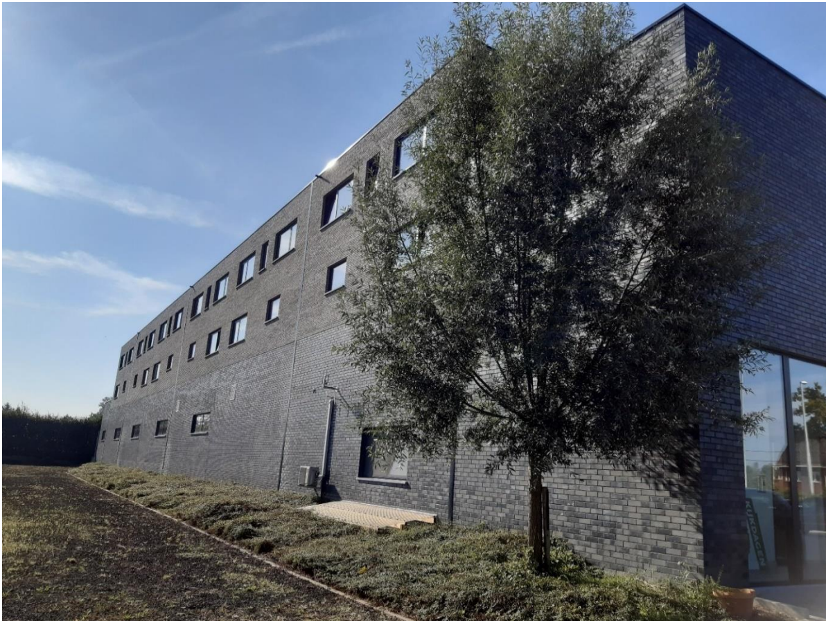
Foto 3: zicht op het gebouwencomplex met onderaan de handelspanden en bovenliggende duplexappartementen vanaf de noordoostzijde. Voor de groenborder ligt een brandweertoegang in steenslag
