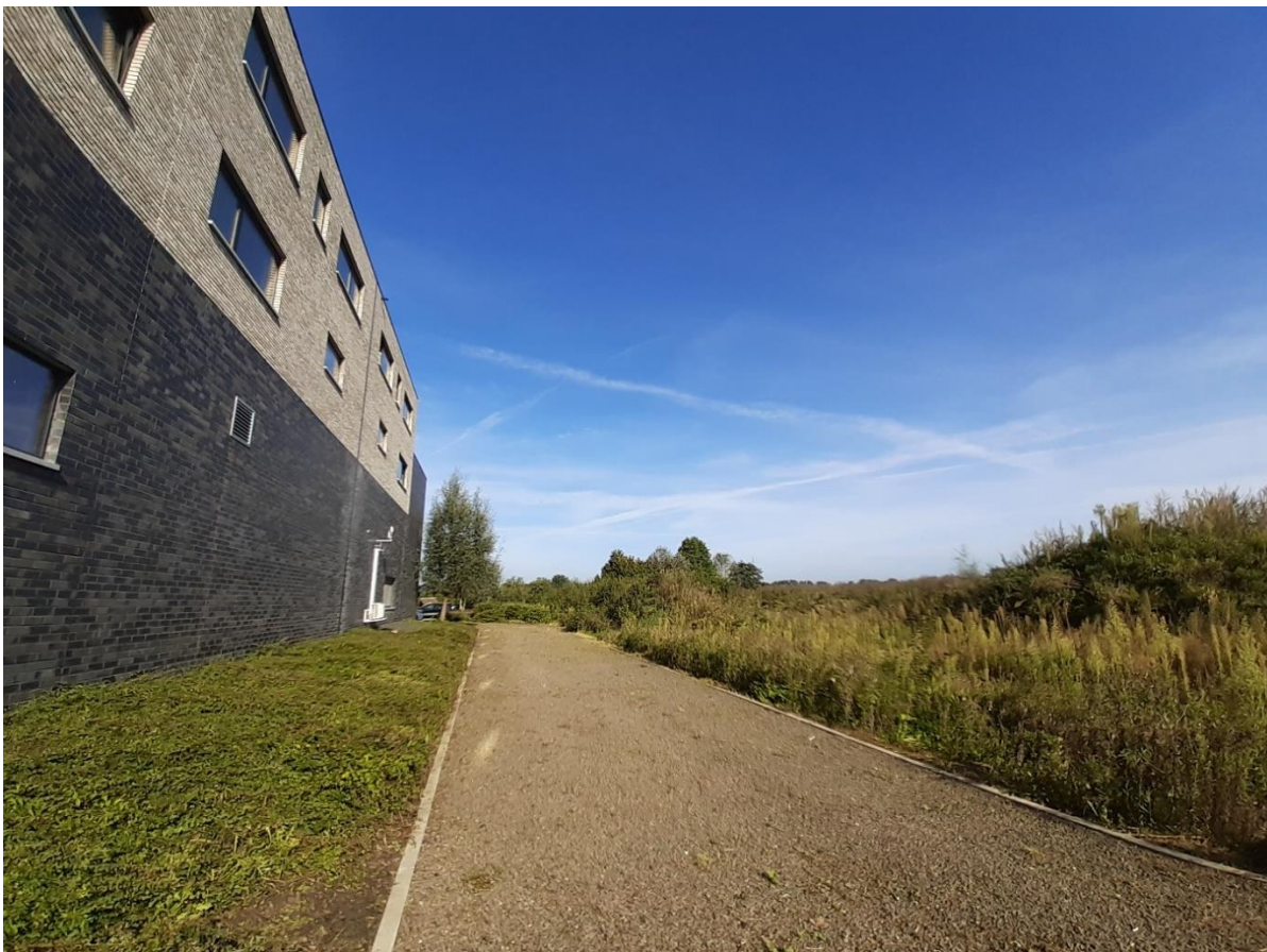
Foto 4: zicht op het gebouwencomplex vanuit de andere hoek, met onderaan de handelspanden en bovenliggende duplexappartementen. Voor de groenborder ligt een brandweertoegang in steenslag
