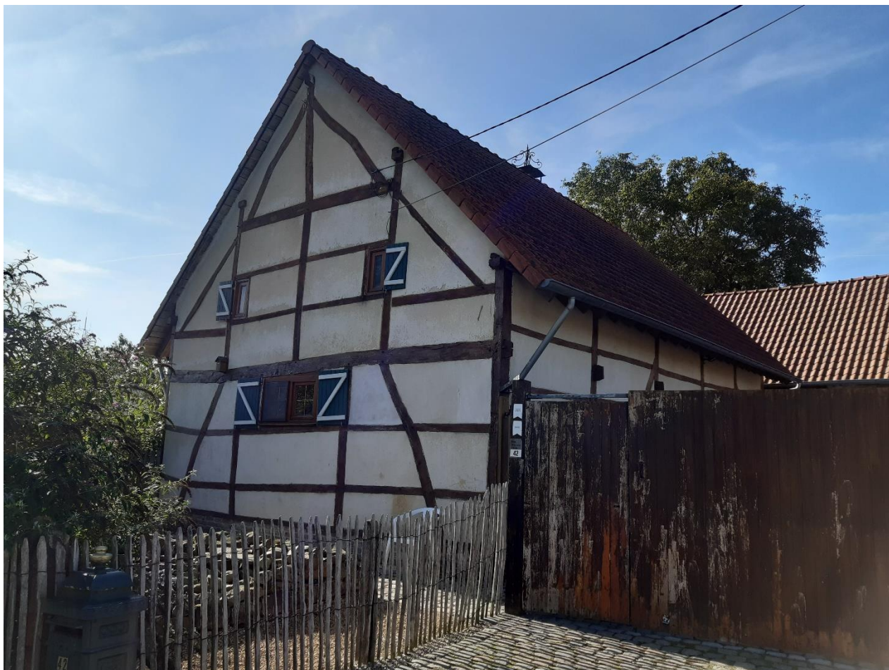
Foto 10: voorgevel van de vakwerkhoeve Herbroekstraat 42
