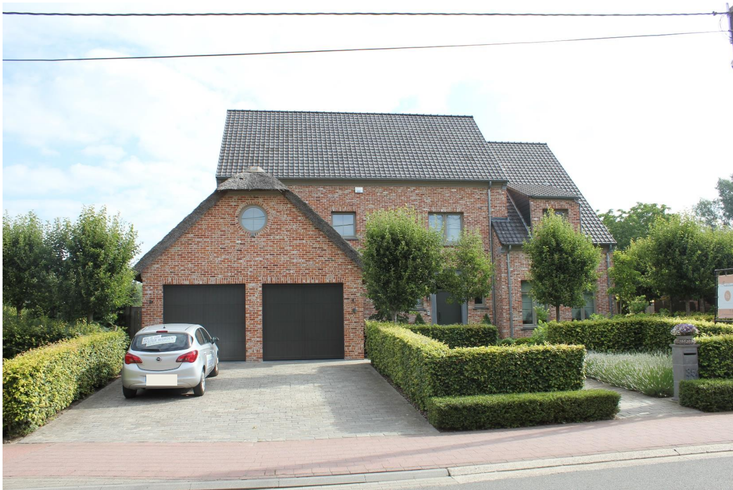
Foto 7: de woning Grouwesteenstraat 35A, gelegen tegenover de voormalige hoeve Grouwesteenstraat 54A-B, 56. De in 1986 gesloopte dwarsschuur stond links van deze woning.
