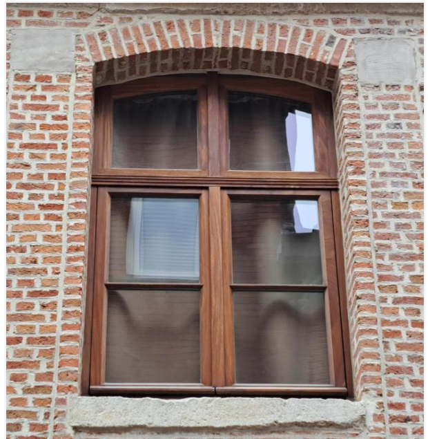
Foto 9: Raam eerste verdieping (15 december 2023)
