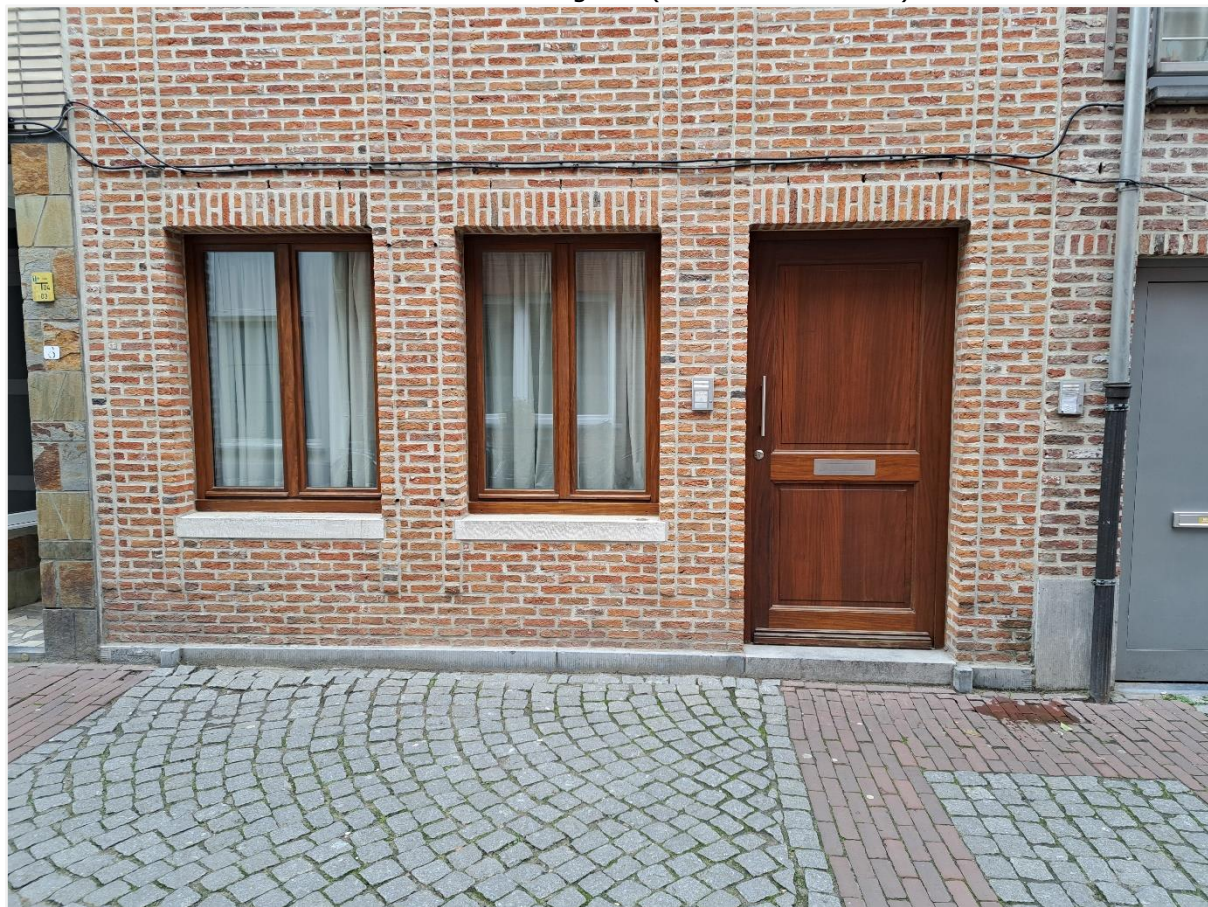
Foto 7: Detail gevel gelijkvloers (15 december 2023)
