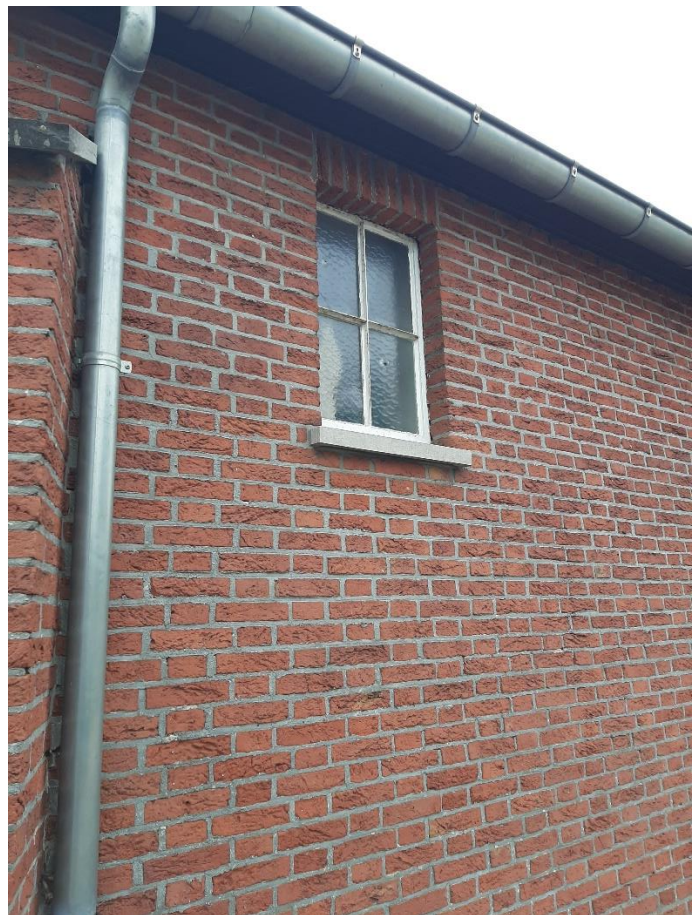
Foto 5: Detail gevelparement kapel van Broekhoven.
