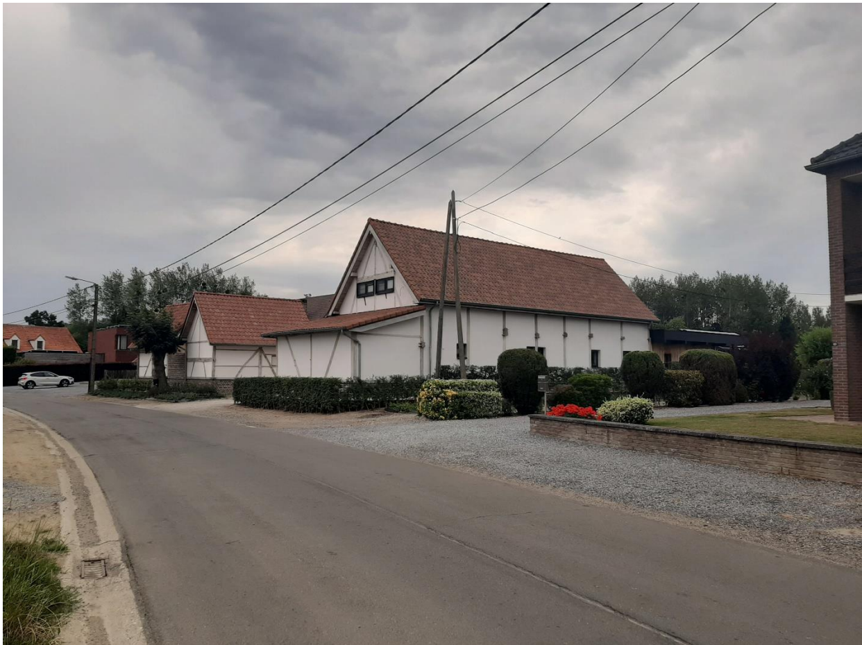
Foto 1: De vakwerkhoeve met losse bestanddelen gezien vanaf de Romershovenstraat.
