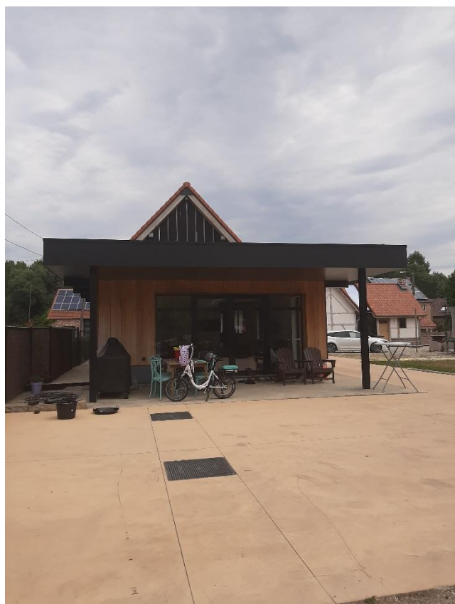
Foto 6: Het woonhuis volume met nieuwe aanbouw gezien vanuit het zuidwesten.
