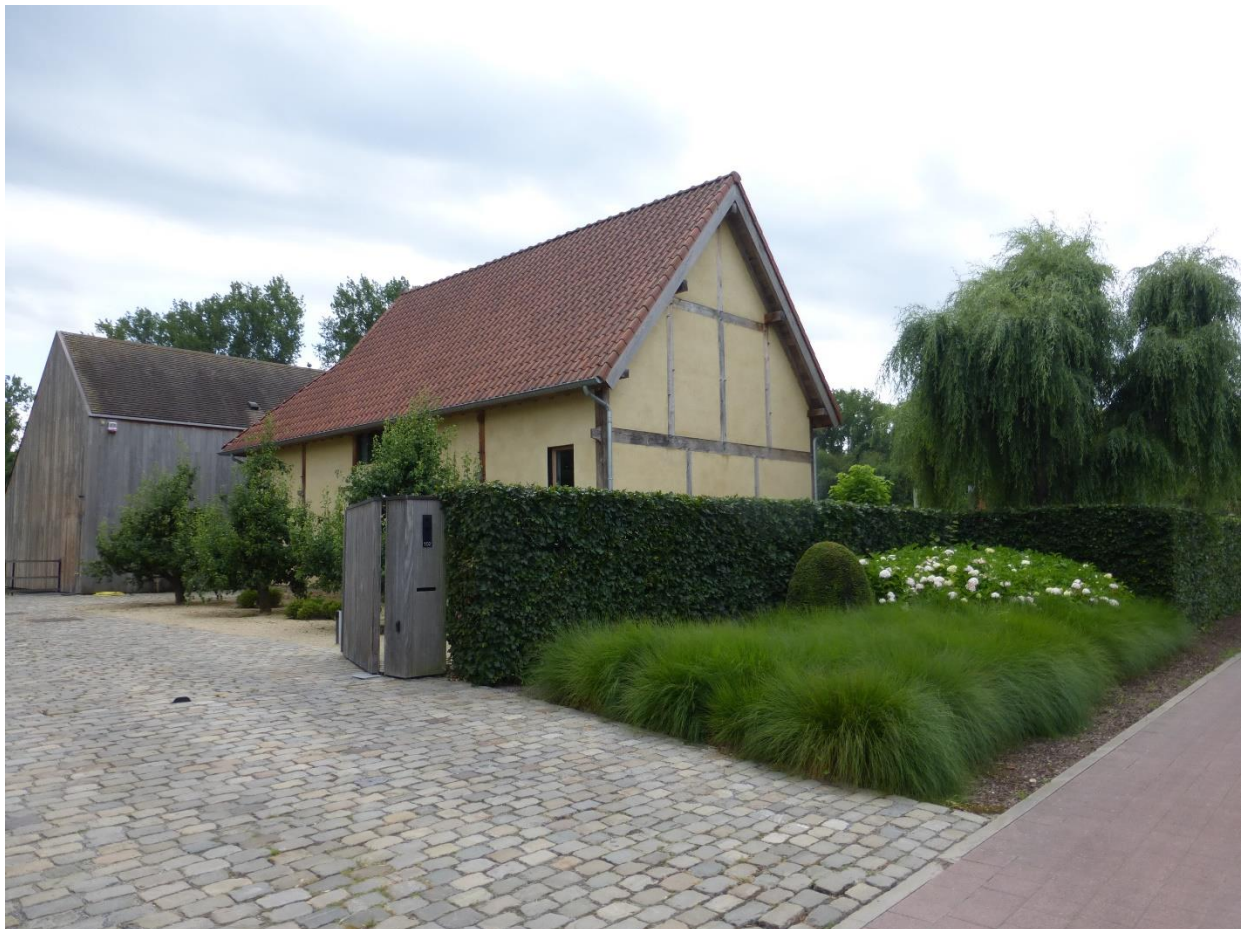
Foto 4: Grootstraat nr. 102, beschermd als monument met achterliggend nieuwe aanbouw.
