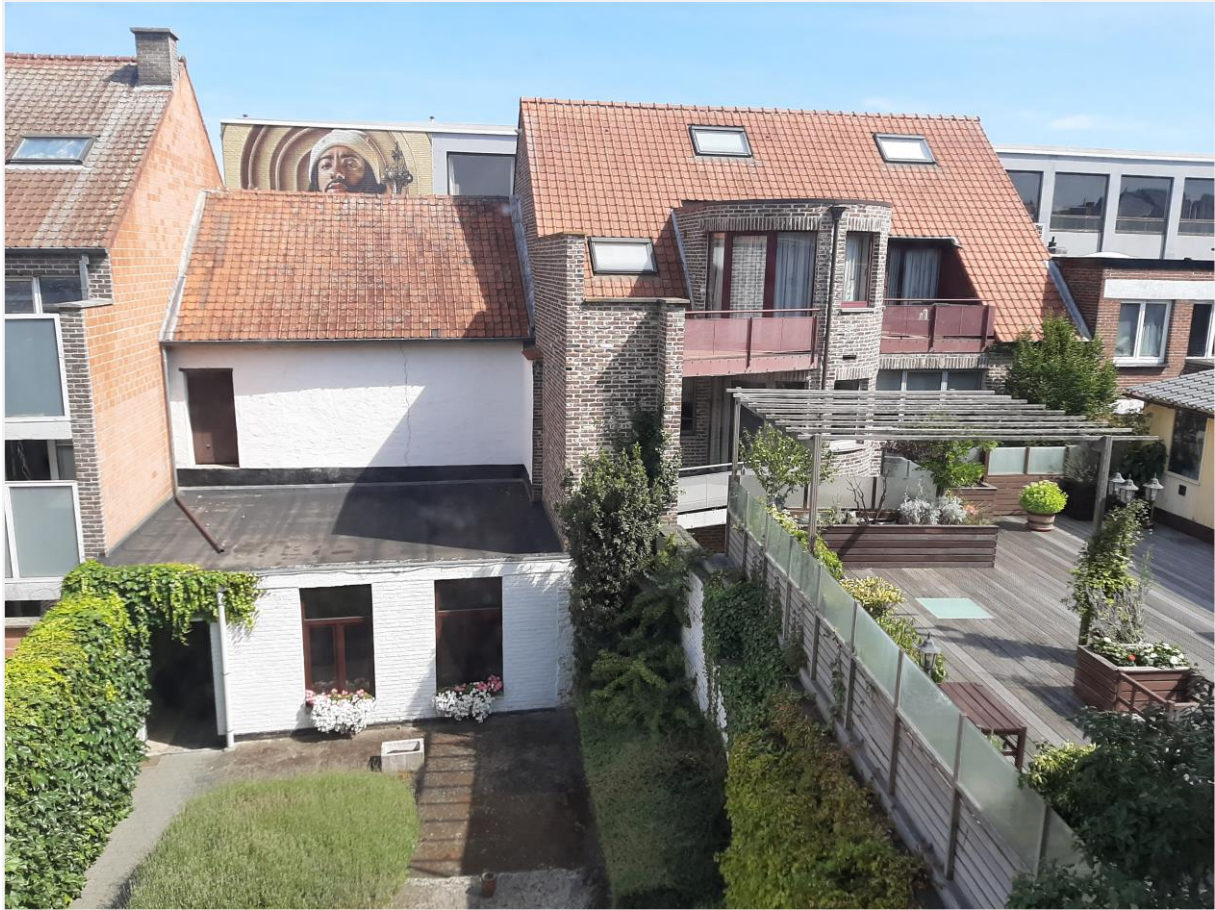
Foto 4: Pelsersstraat 56-58: achtergevels met links bewaard volume van nummer 58 en rechts nieuwbouw van nummer 56
