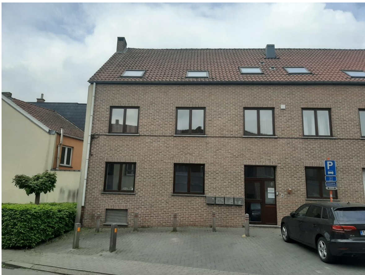
Foto 3: Zicht op het beschermde stadsgezicht met Verlatstraat nummer 4 en het voorliggend pleintje.
