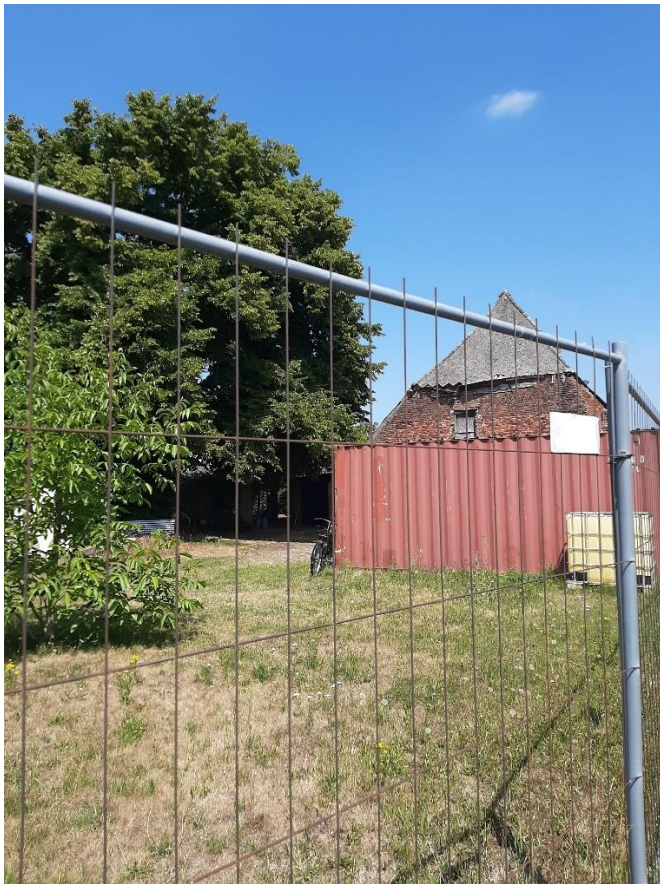
Foto 4: De zuidzijde van Hoeve Spooren gezien vanaf de straat Loberg, ter hoogte van de ingestorte schuur, 29 juli 2022.
