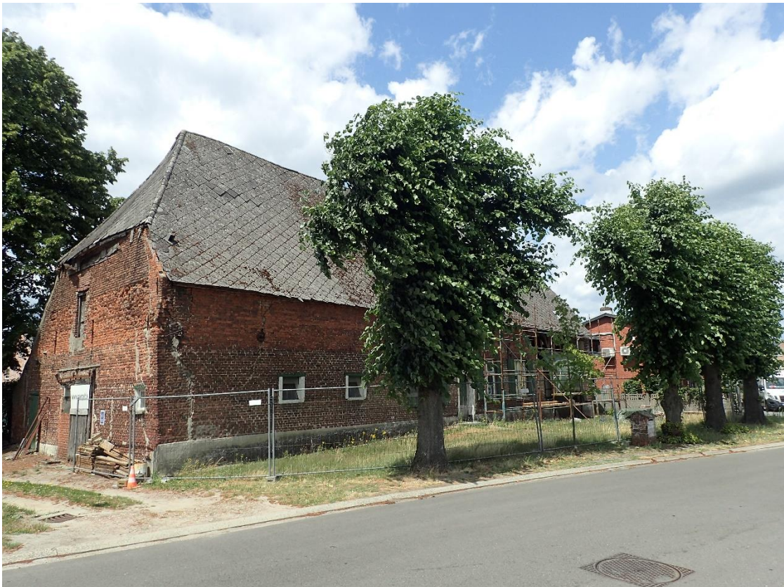
Foto 8: Gekandelaarde scherm lindes bij Hoeve Spooren, gezien vanuit het zuiden (5 juli 2023).
