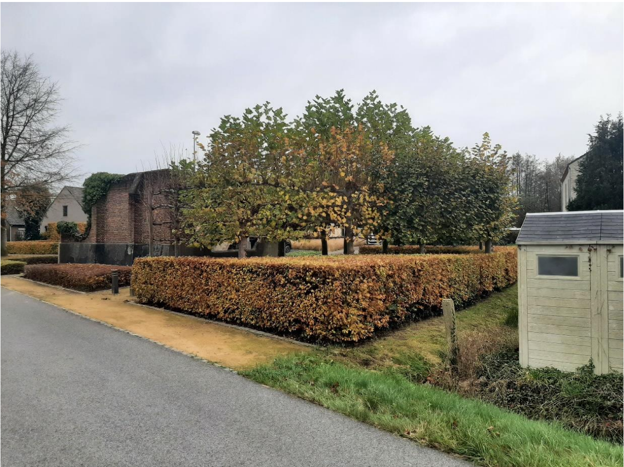
Foto 6: zicht op de Sint-Luciakapel en het parkje met lindes vanuit het noordwesten.
