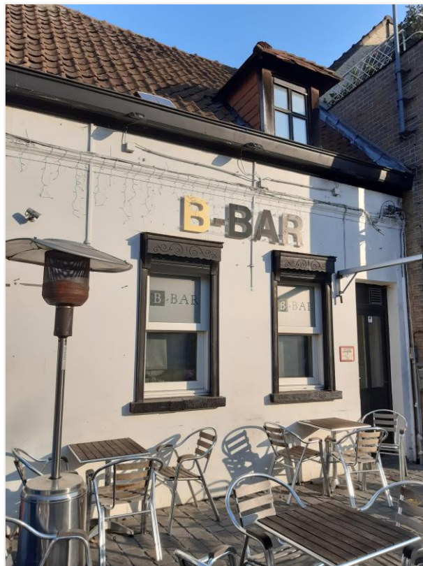
Foto 4: Dorpswoning, Drongenplein 15 bepleisterde lijstgevel met overschilderde rolluikkasten en kroonlijst (© agentschap Onroerend Erfgoed 24 maart 2022).
