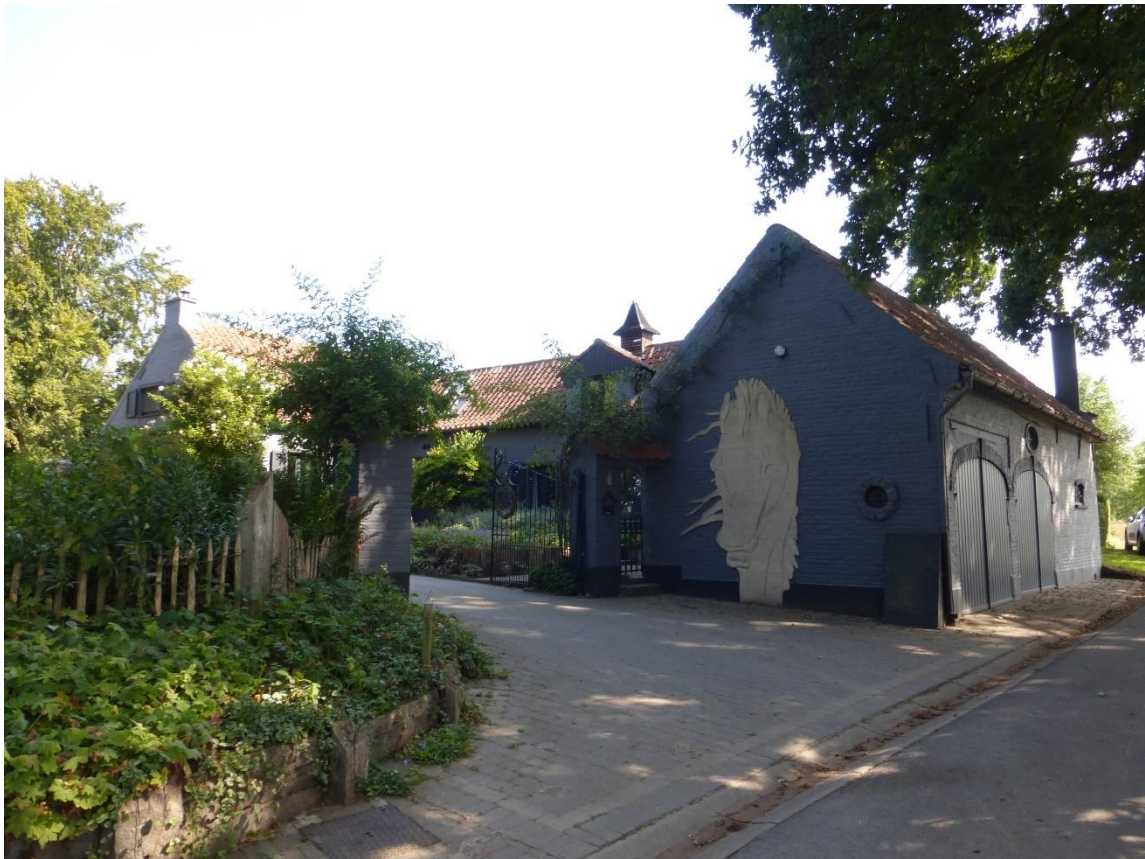
Foto 1. Algemeen beeld van de hoeve vanaf de straat (vanuit het westen). Het woongedeelte (oostvleugel) is geflankeerd door twee zijvleugels. Recent grijs geschilderde baksteenbouw boven gepekte plint.
