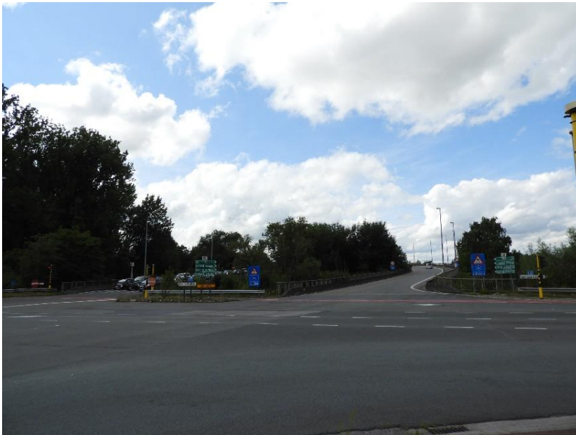
Foto 1: brug van de R8 over de Leie
