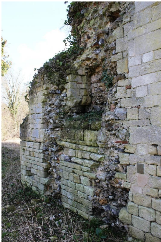
Foto 31: uitbraakspoor van een verdwenen aanbouw op de noordwestelijke zijde van de donjon (15 februari 2022).
