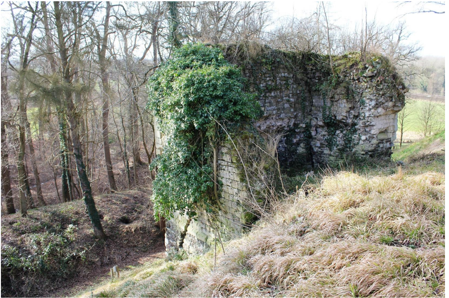
Foto 13: intra muros zijde van de toren in de omheining van het neerhof (15 februari 2022).
