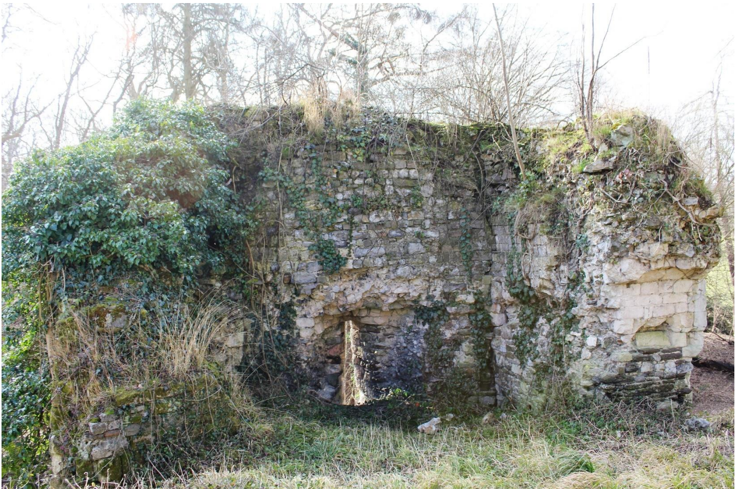
Foto 14: intra muros zijde van de toren in de omheining van het neerhof (15 februari 2022).
