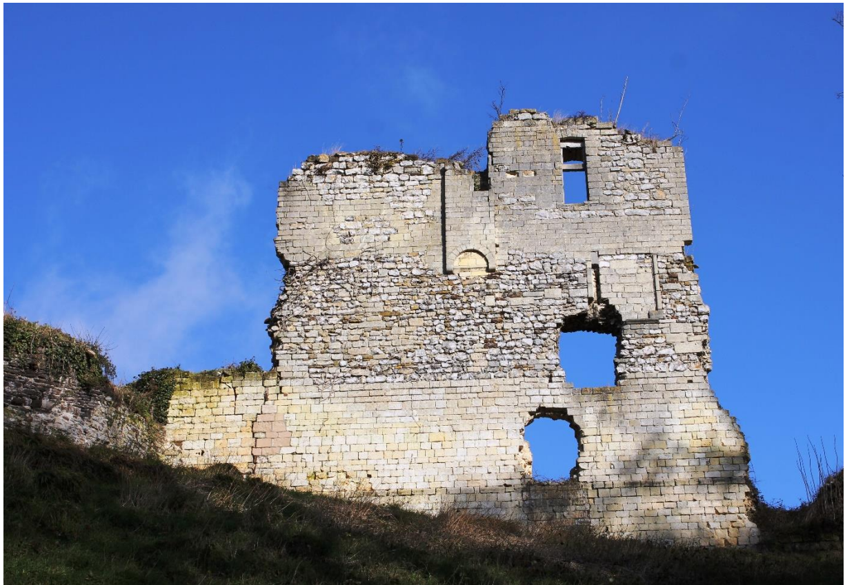
Foto 17: de extra muros zijde van het overblijfsel van de zogenaamde "love" (15 februari 2022). Links een deel van de keermuur rond de donjon.
