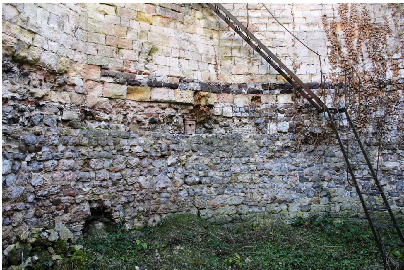
Foto 33: binnenzijde van de donjon met ronde onderbouw en metalen trap uit de 19de eeuw (15 februari 2022).
