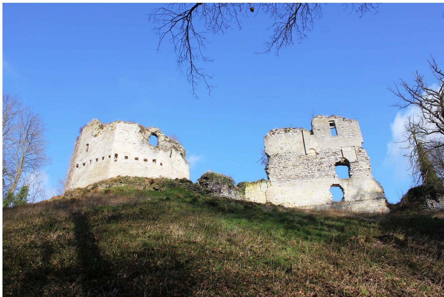
Foto 26: zicht op de donjon (links) en het overblijfsel van de zogenaamde "love" (15 februari 2022).
