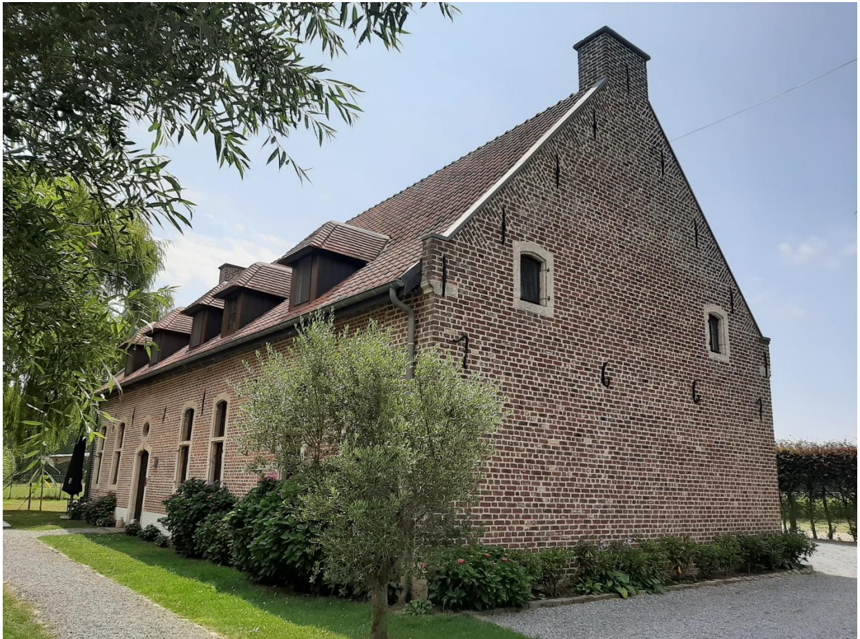
Foto 4: De noordwestelijke gereconstrueerde gevel met 1661 aangeduid door ankers en de noordoostelijke gevel.
