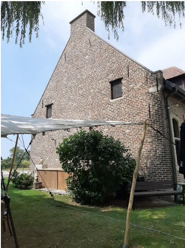
Foto 5: De zuidoostelijke gereconstrueerde gevel.
