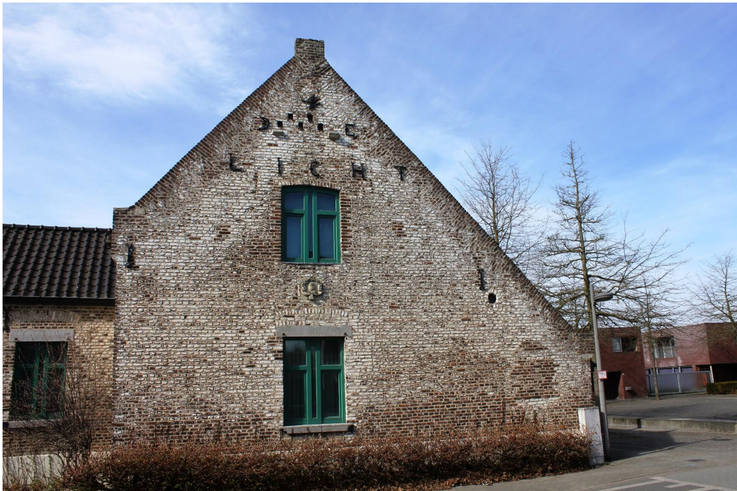
Foto 4: zijgevel van de noordvleugel van de hoeve De Licht (13 maart 2022)
