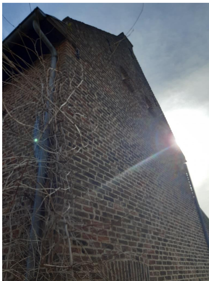
Foto 4 - Zicht op de zuidelijke topgevel van de voormalige 'leerlooiërij' (© Onroerend Erfgoed).
