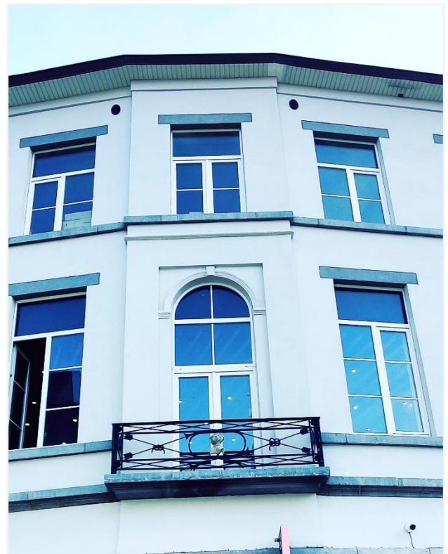
Foto 3: voorgevel: detail risalietvormend travee
