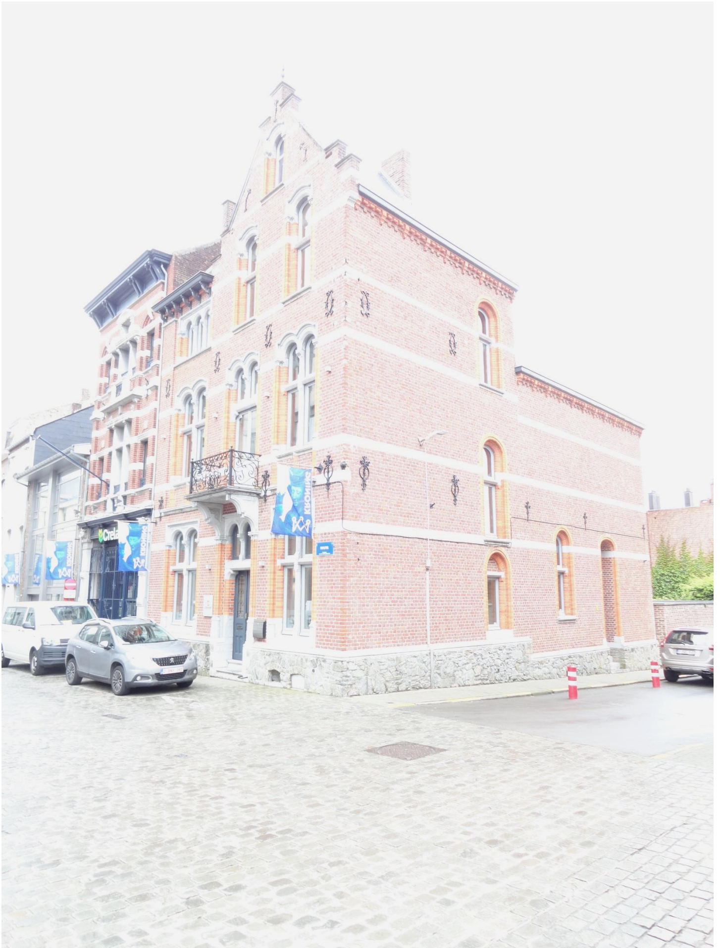
Foto1: Het huis Piepelpoel 13, op de hoek van de Piepelpoel en de Corversstraat.
