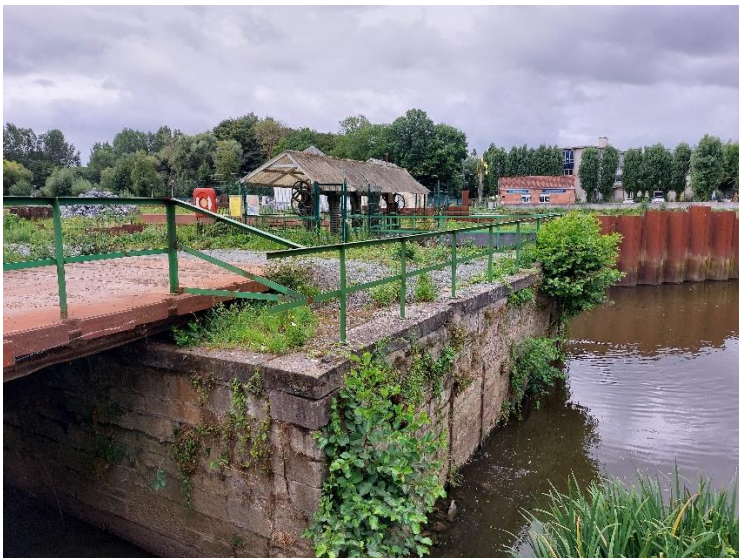
Foto 15: Muur ten oosten van kleine stuw
