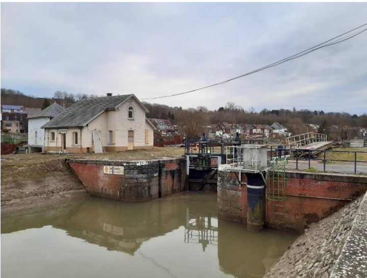
Foto 9: De sluis en het sashuis
