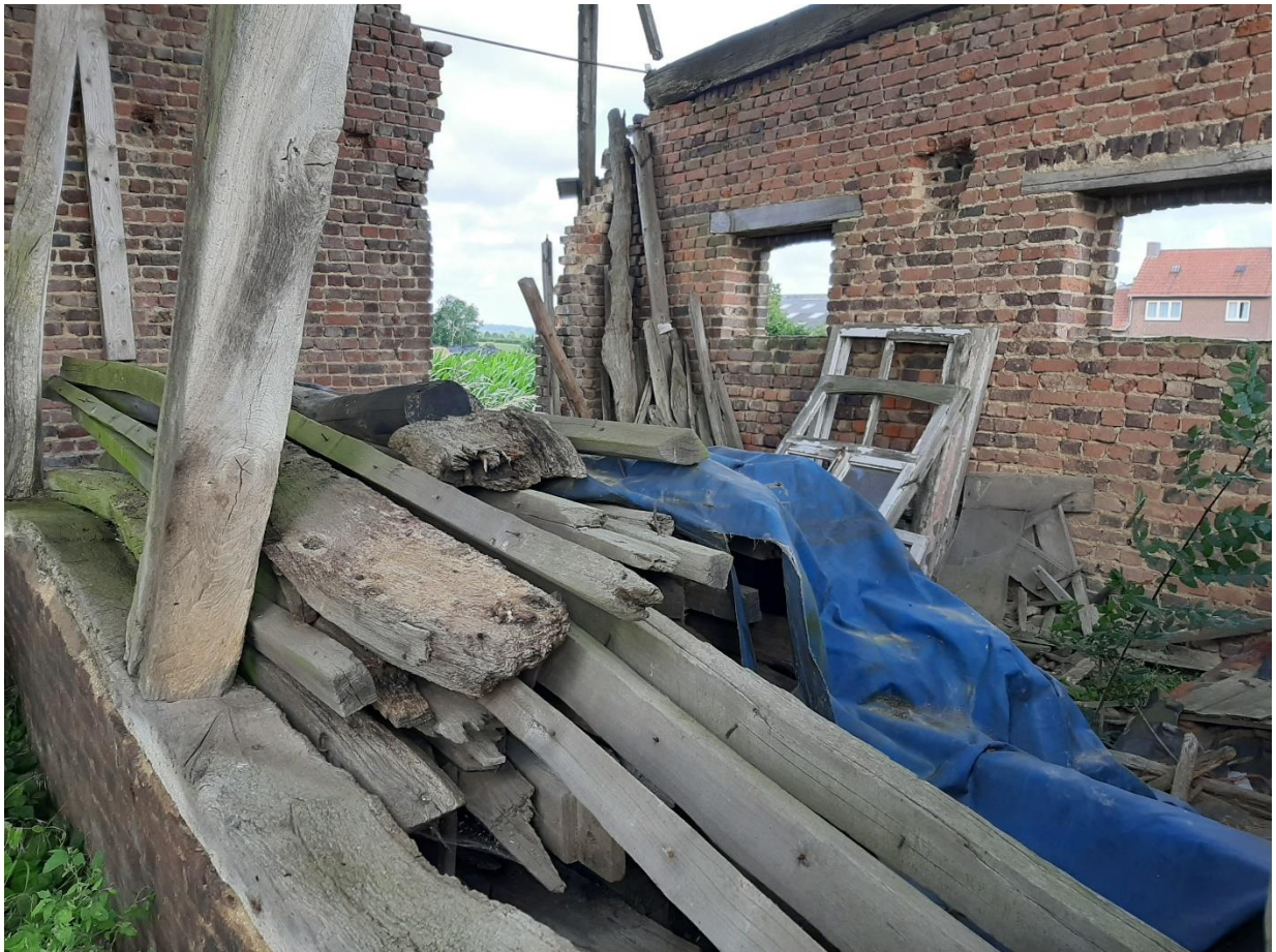
Foto 8: Interieur van de vakwerkschuur.
