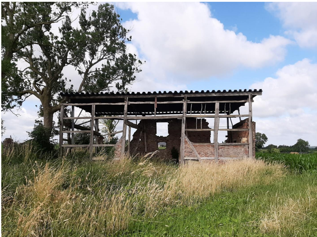
Foto 2: De oostgevel van de vakwerkschuur.
