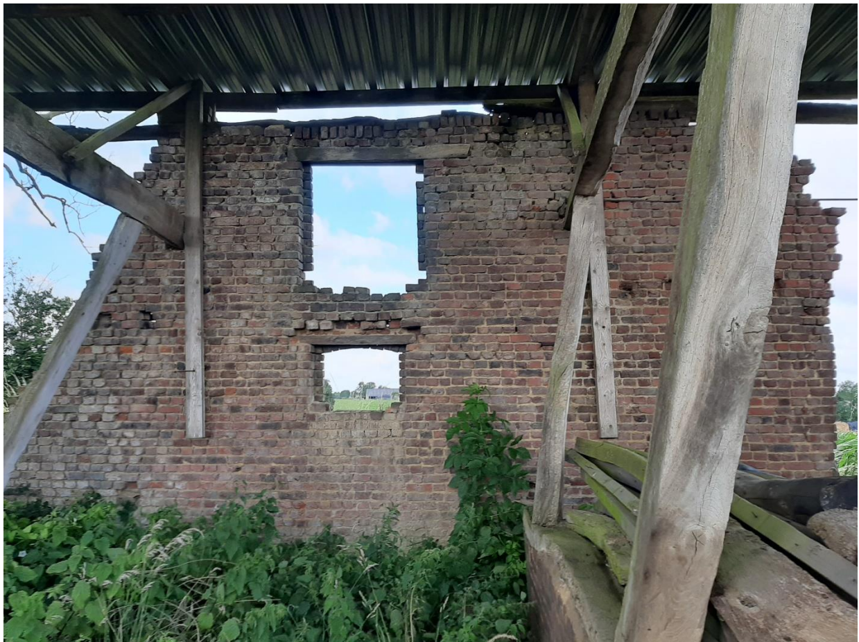
Foto 9: Interieur van de vakwerkschuur.
