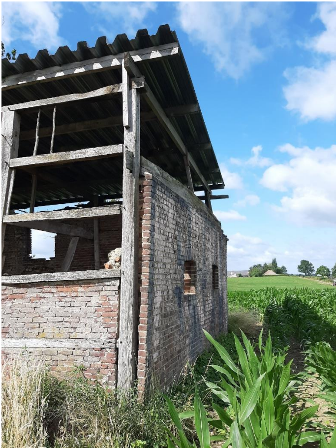
Foto 6: Detail van de noordgevel van de vakwerkschuur.
