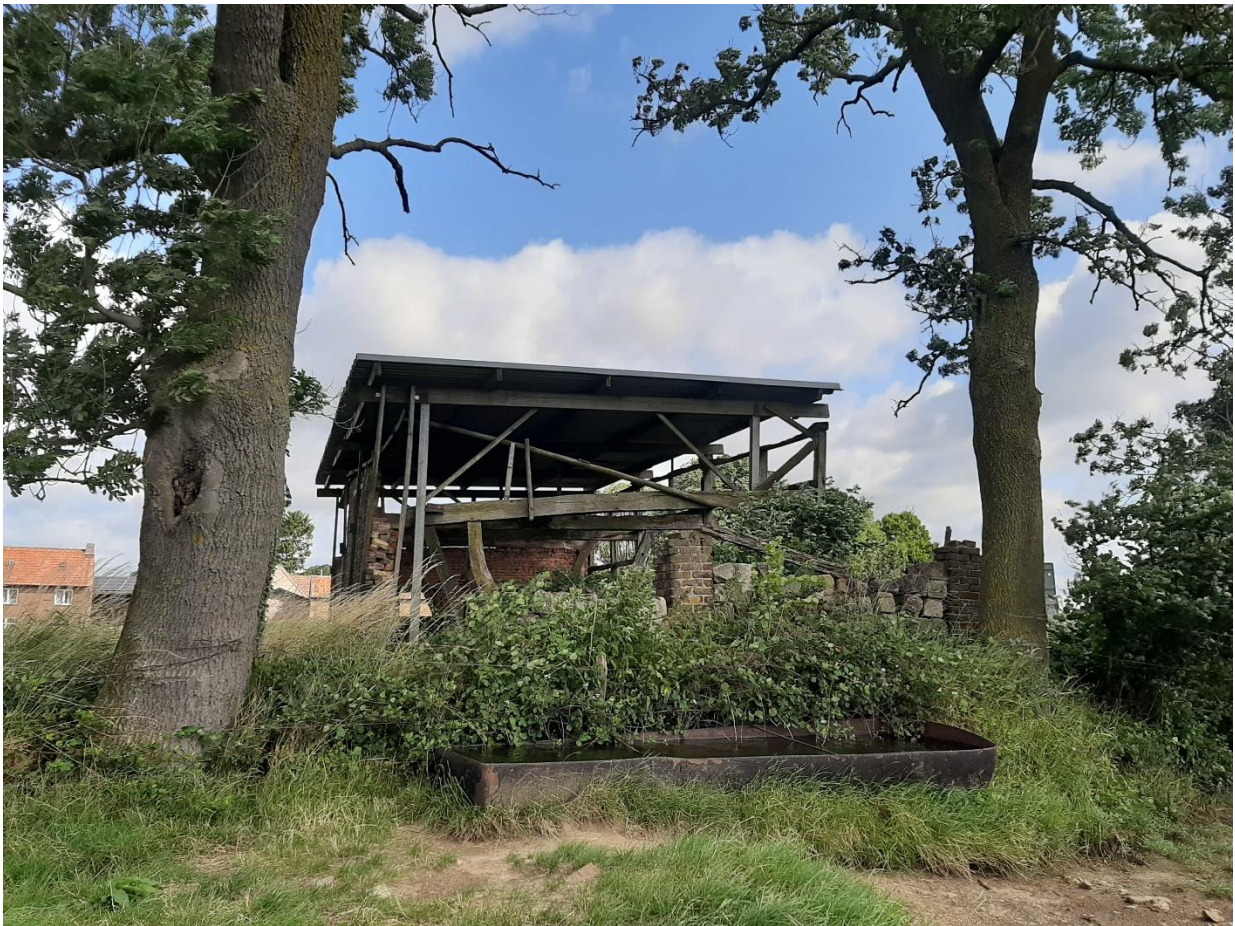
Foto 3: De zuidgevel van de vakwerkschuur.
