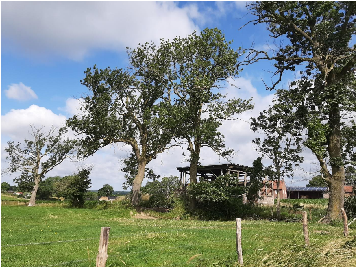
Foto 5: De vakwerkschuur en omgeving gezien vanuit het zuiden.
