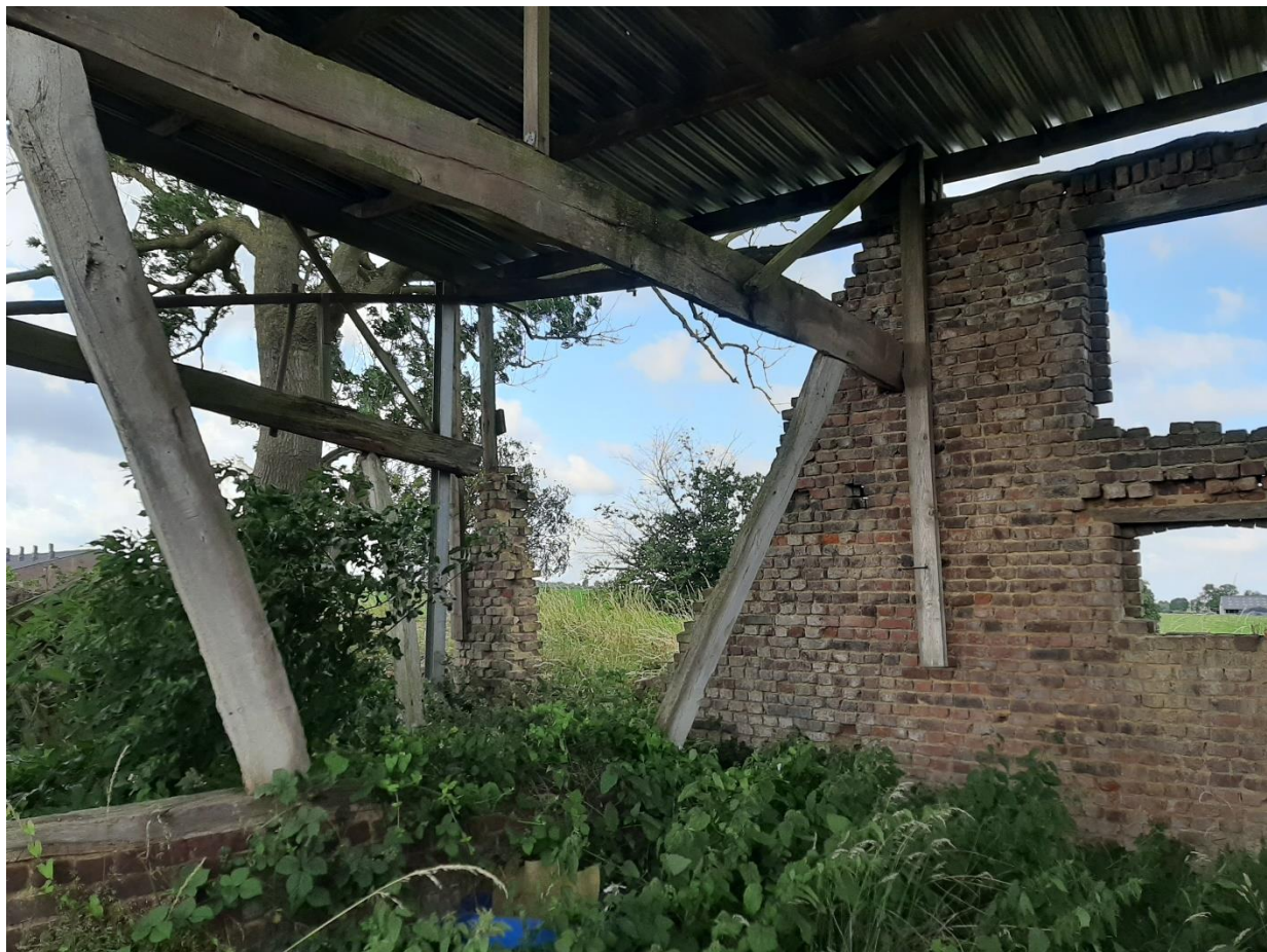
Foto 10: Interieur van de vakwerkschuur.
