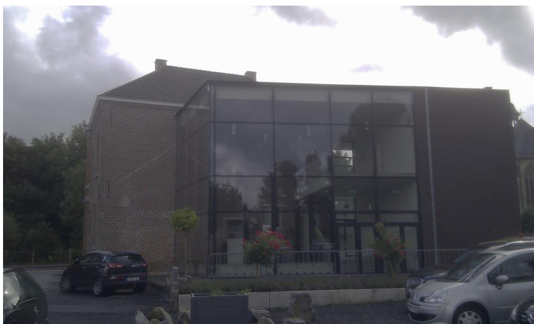
Foto 4: algemeen zicht op de nieuwbouw en de parkeerzone.
