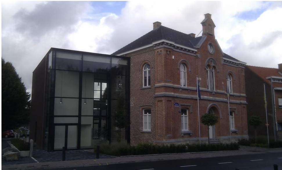
Foto 1: algemeen zicht op de onderwijzerswoning en nieuwe aanbouw.
