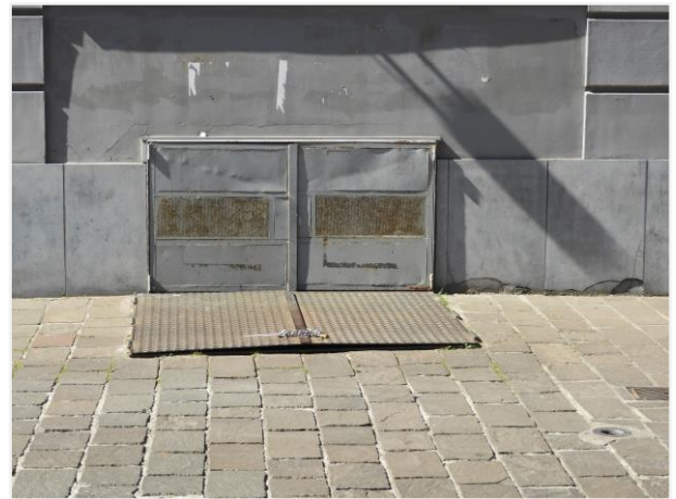
Foto 2: Hoogpoort, toegang tot de kelders
