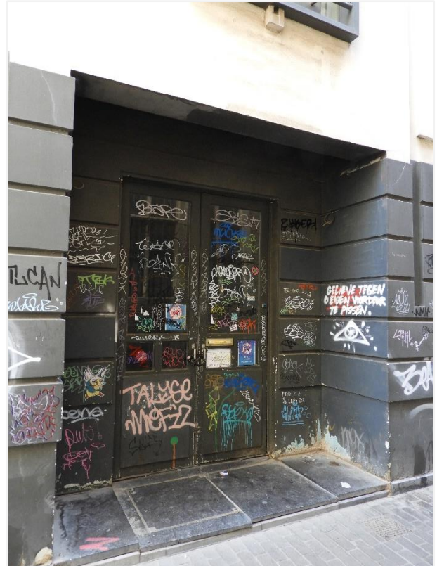
Foto 4: Stadhuissteeg 3, toegang tot de kelders
