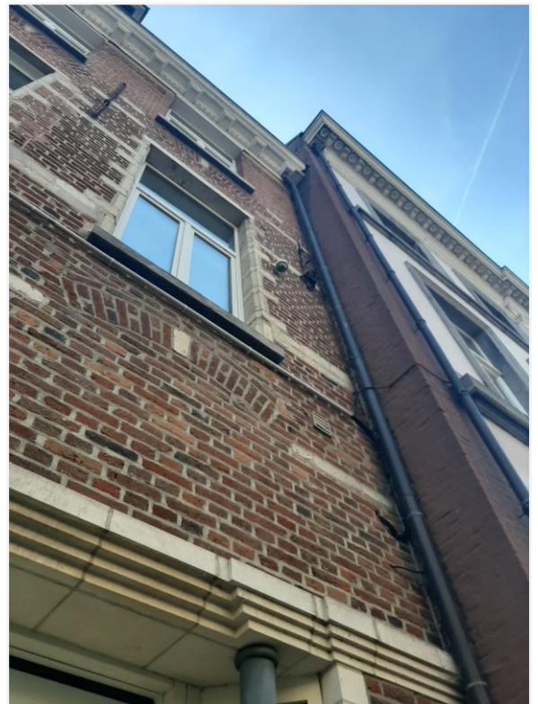
Foto 5: Huys van de Vrouwe van Spagne, nummer 67, voorgevel, detail bovenverdiepingen.
