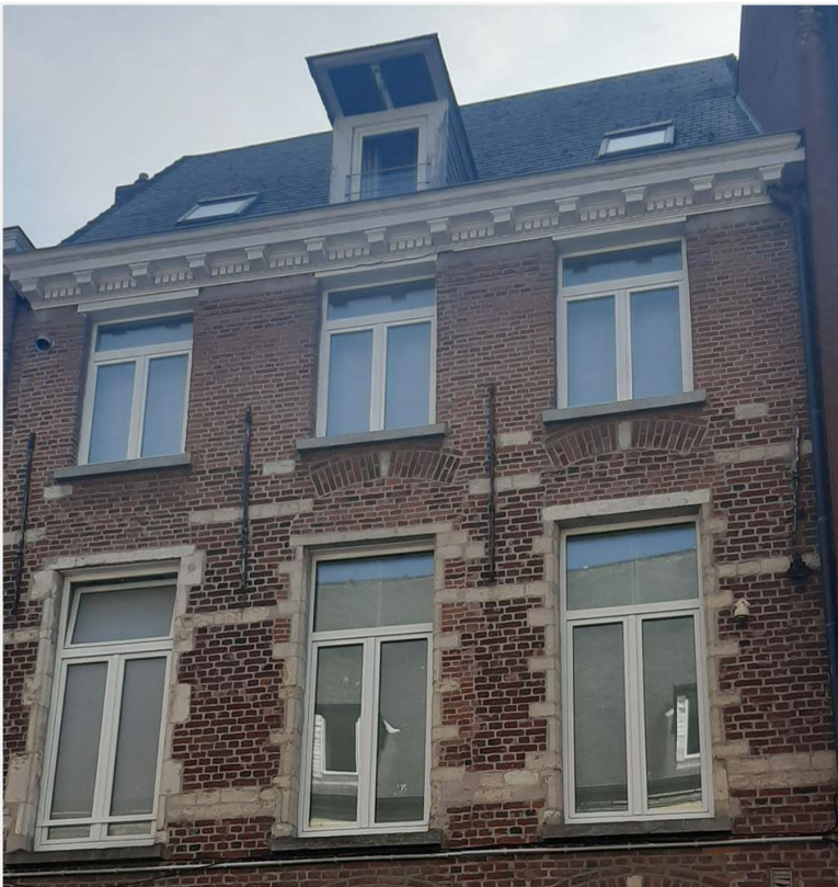
Foto 4: Huys van de Vrouwe van Spagne, nummer 67, voorgevel, detail bovenverdiepingen.
