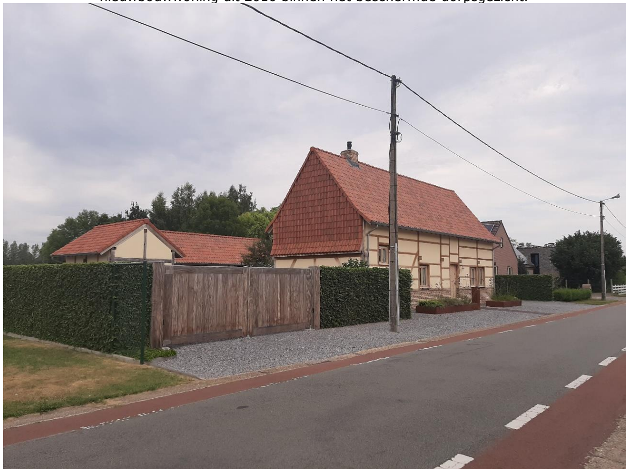
Foto 2: De semi-gesloten vakwerkhoeve gezien vanaf de straatzijde.
