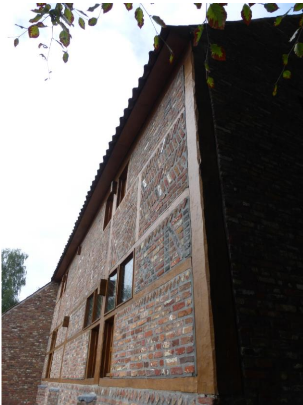
Foto 6. De gereconstrueerde vakwerkgevel op hoge bakstenen plint – hoge stijl als overgang naar de rechter zijgevel.
