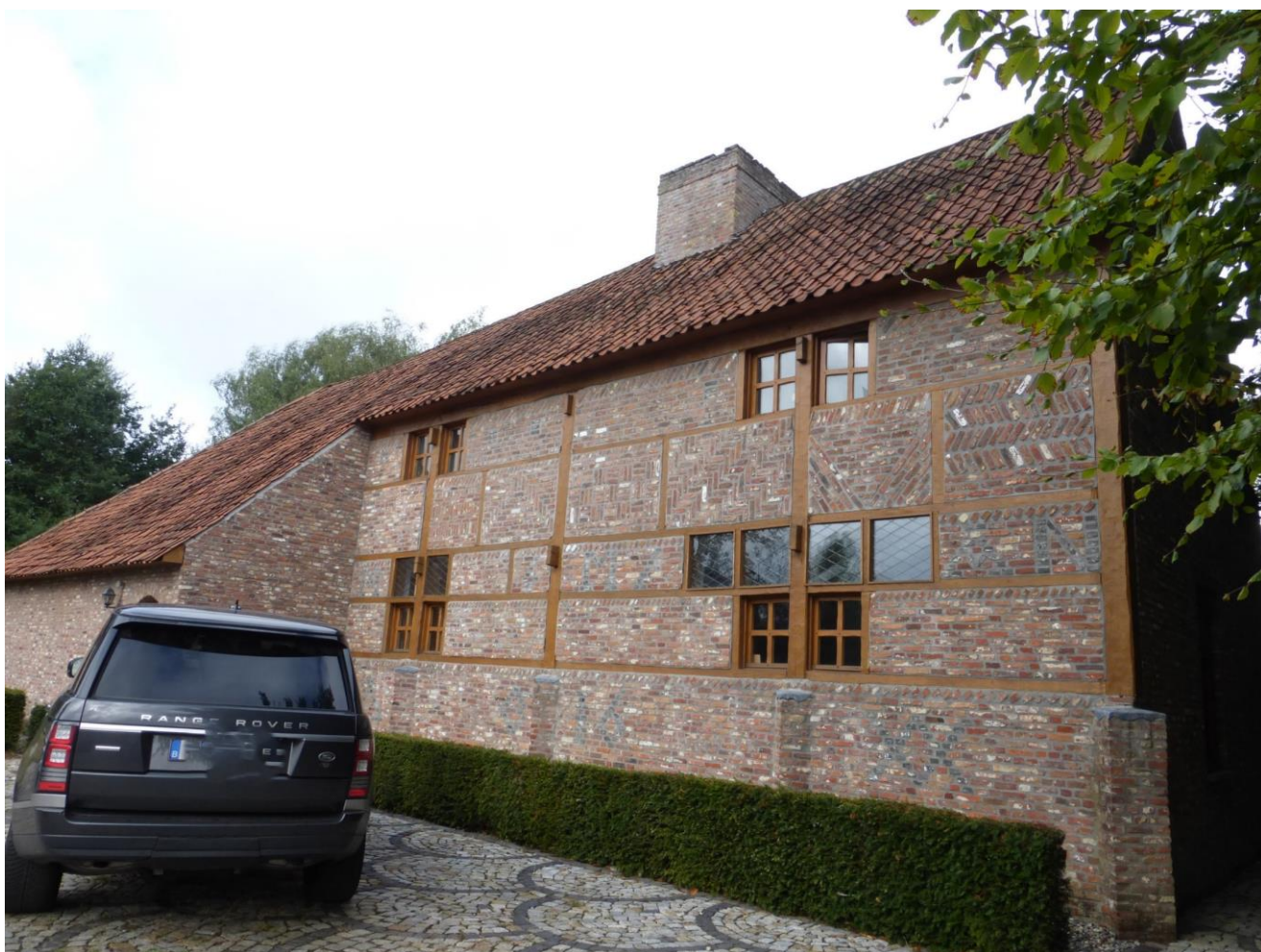
Foto 4. De gereconstrueerde vakwerkgevel met sierpatronen op hoge bakstenen plint. De (Romeinse) cijfers en letters met vermoedelijke datering 1680 zijn (ter hoogte van de bovenlichten en in de plint) in gesmoorde baksteen uitgevoerd.
