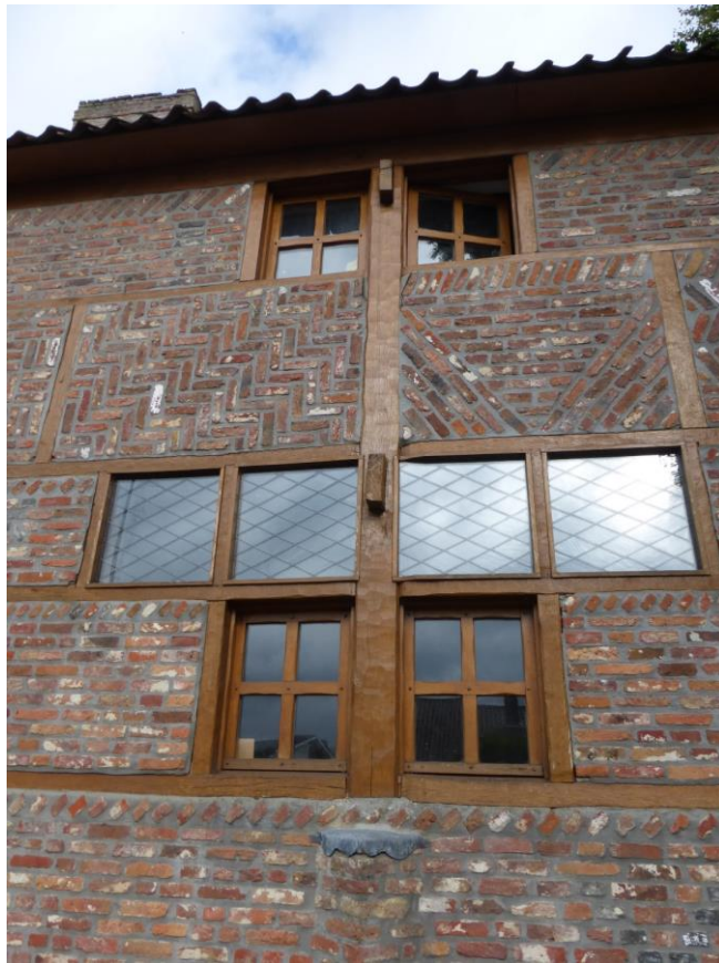
Foto 5. De gereconstrueerde vakwerkgevel op hoge bakstenen plint. Houten kozijnconstructies.
