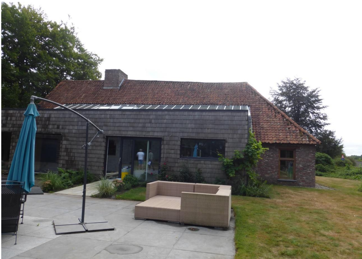
Foto 9. De achterbouw met ontspanningsruimte (buiten de beschermde perimeter) is als het ware ingeschoven in de lage achtergevel van het beschermde gebouw. Een schuine beglazing tussen Pannenhuis en achterbouw brengt licht in het historische volume.
