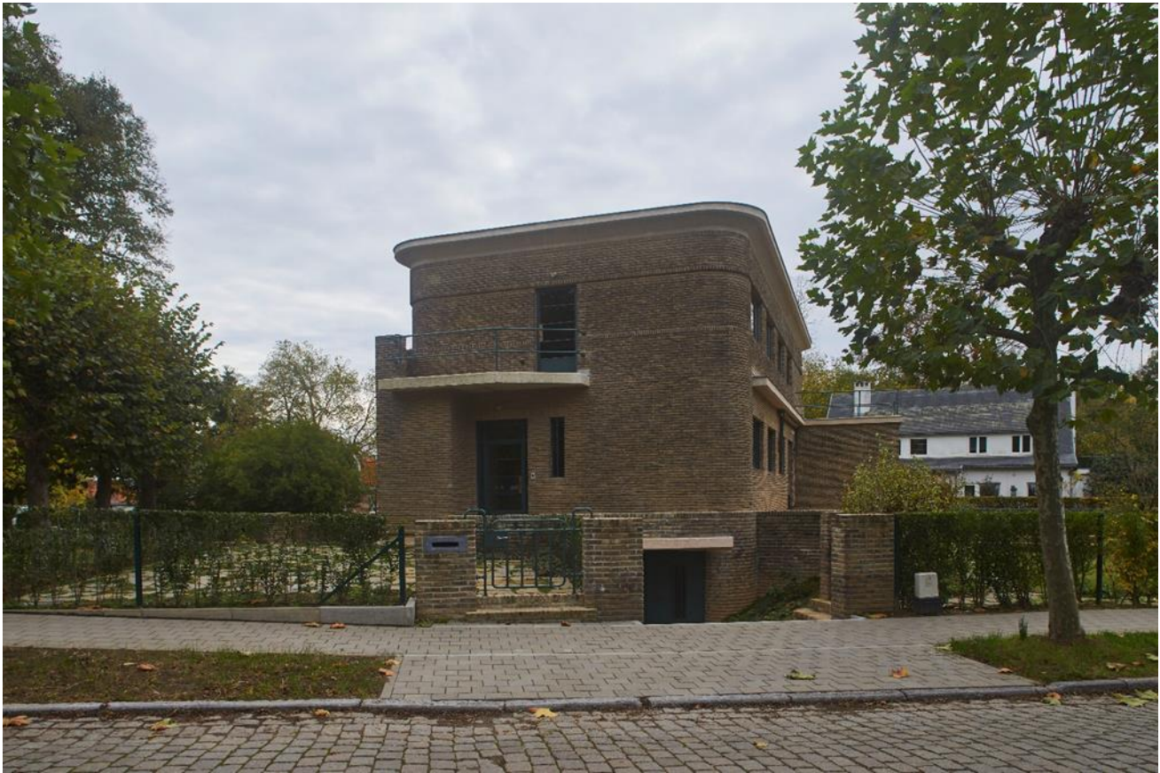
Foto 1: Noordwestgevel met toegangshek.
