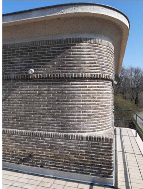
Foto 10: afgeronde hoek op de 1ste verdieping, zuidgevel.
