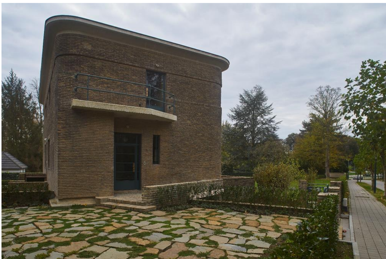
Foto 2: Toegangszone met terras in flagstones.
