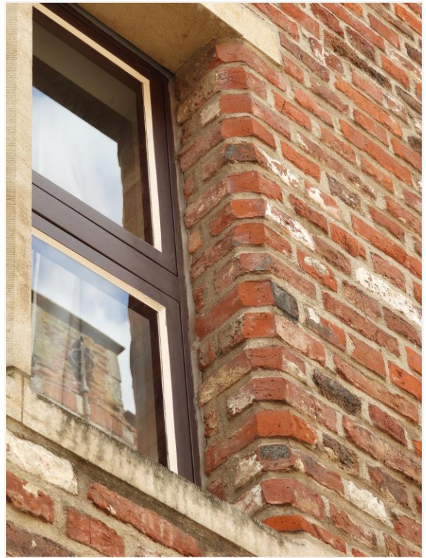
Foto 6: machinale afwerking van de dagkanten van de vensters
