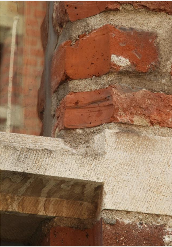
Foto 5: machinale afwerking van de dagkanten van de vensters
