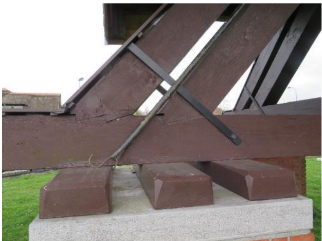
Foto 25 – De lange en korte steekbanden.
