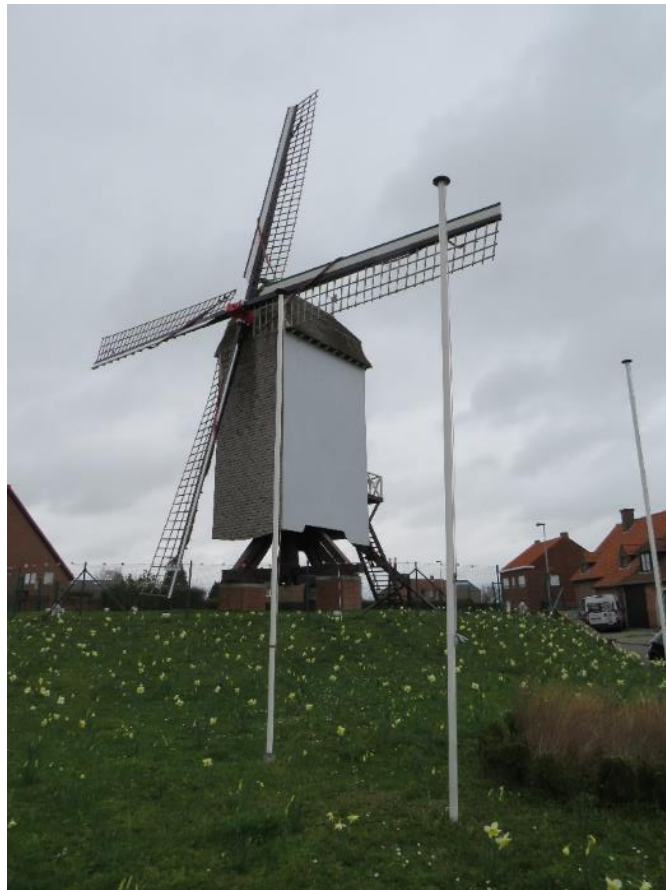
Foto 18 - Zicht op de Ma Campagnemolen vanuit het zuiden.
