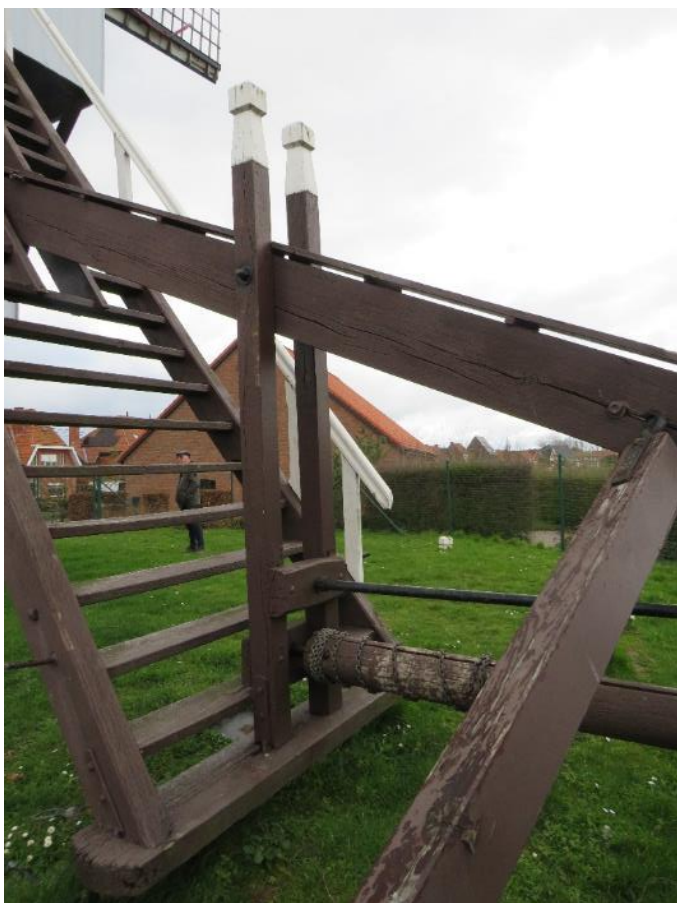
Foto 29 – Molentrap en staartbalk met kruitwerk.
