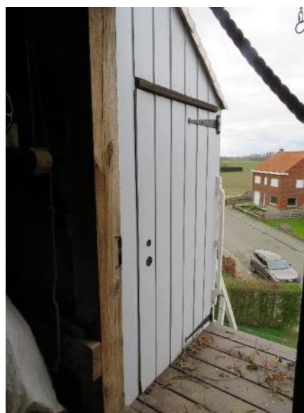
Foto 28 a & b – Staartbalk, molentrap en balkon met kombuis.
