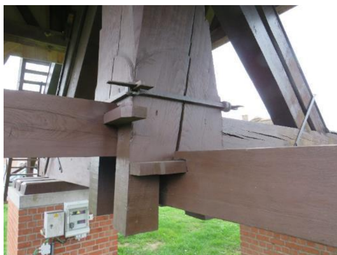
Foto 24 – De door kruisplaten gedragen standaard.
