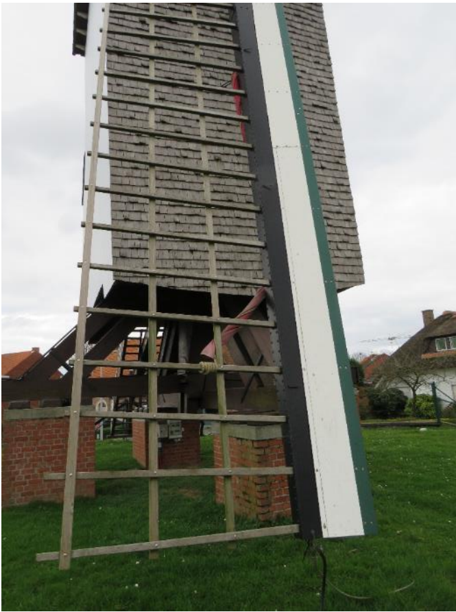
Foto 35 – Hekwerk van het gevlucht.
