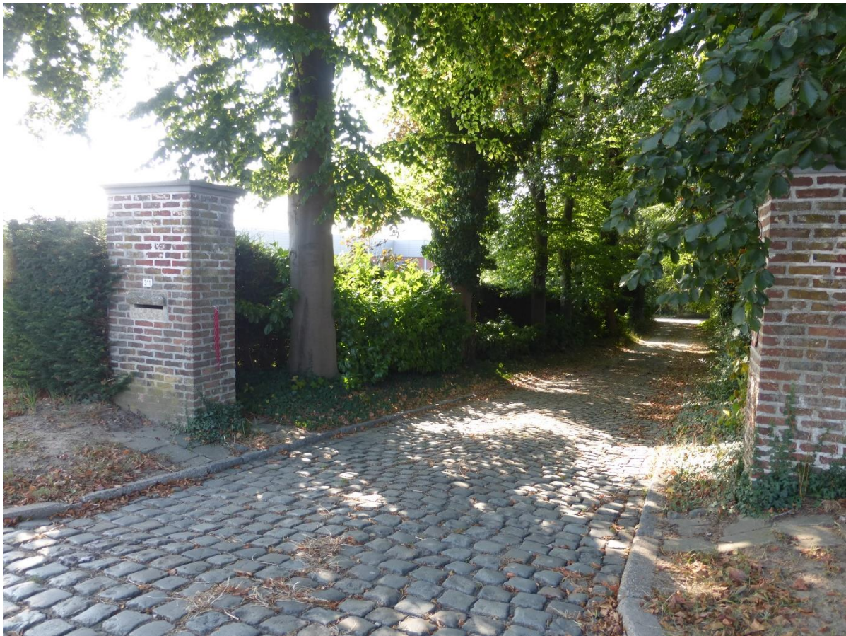
Foto 1. De gekasseide erfoprit met vernieuwde hekpijlers.
