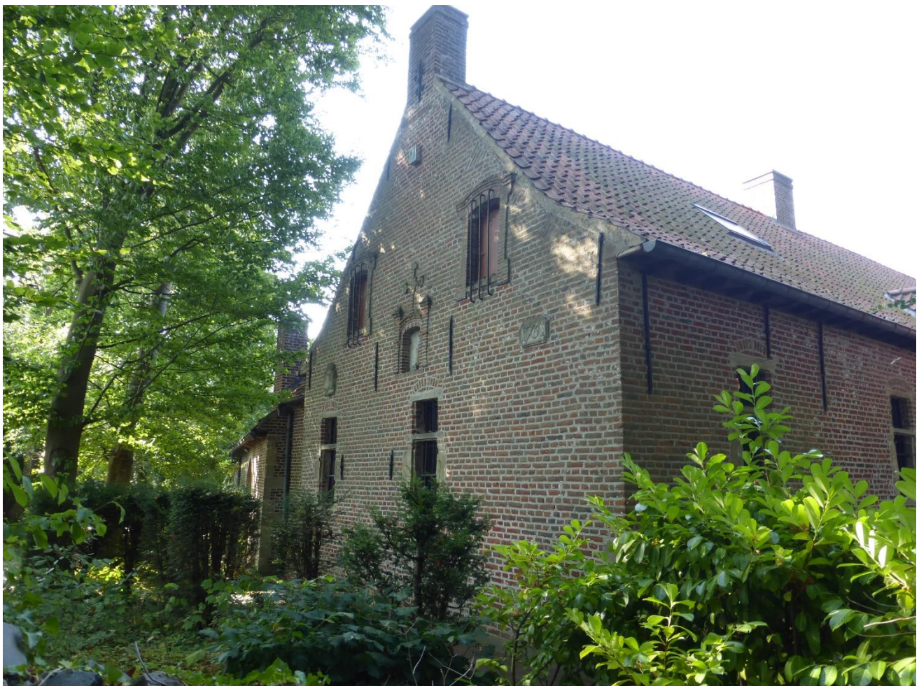
Foto 2. De noordoostelijke zijgevel van de woning.
