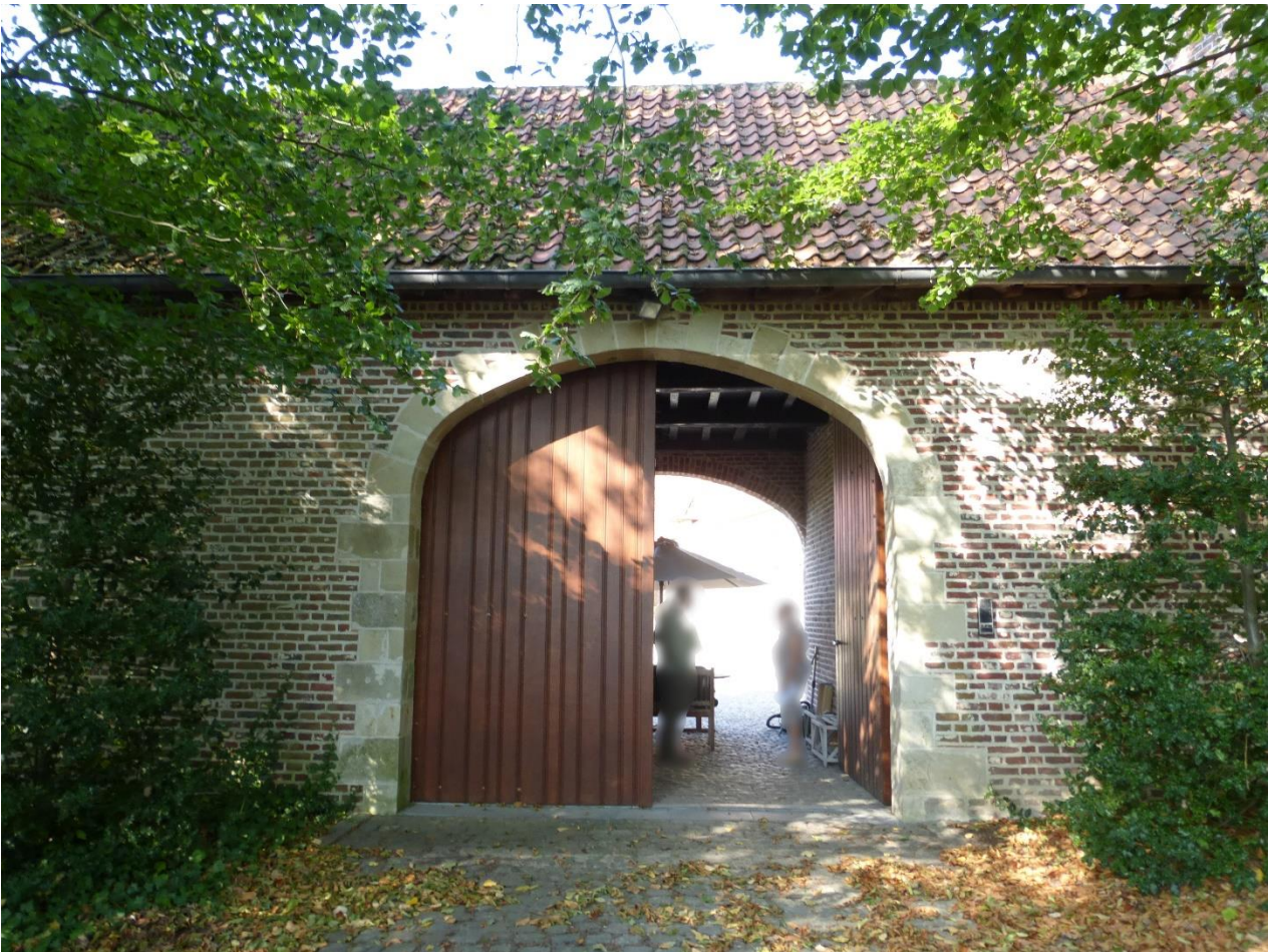
Foto 6. De korbogige poortdoorrit van het schuur- en stalvolume vormt een nieuw element. Hetzelfde geldt voor de omlijsting in natuursteen.
