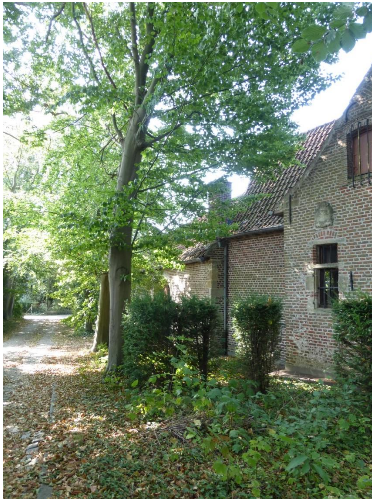
Foto 3. De directe aansluiting tussen woonhuis en het schuur- en stalvolume bestond niet voor de verbouwing. Nieuwe hoekketting in natuursteen.
