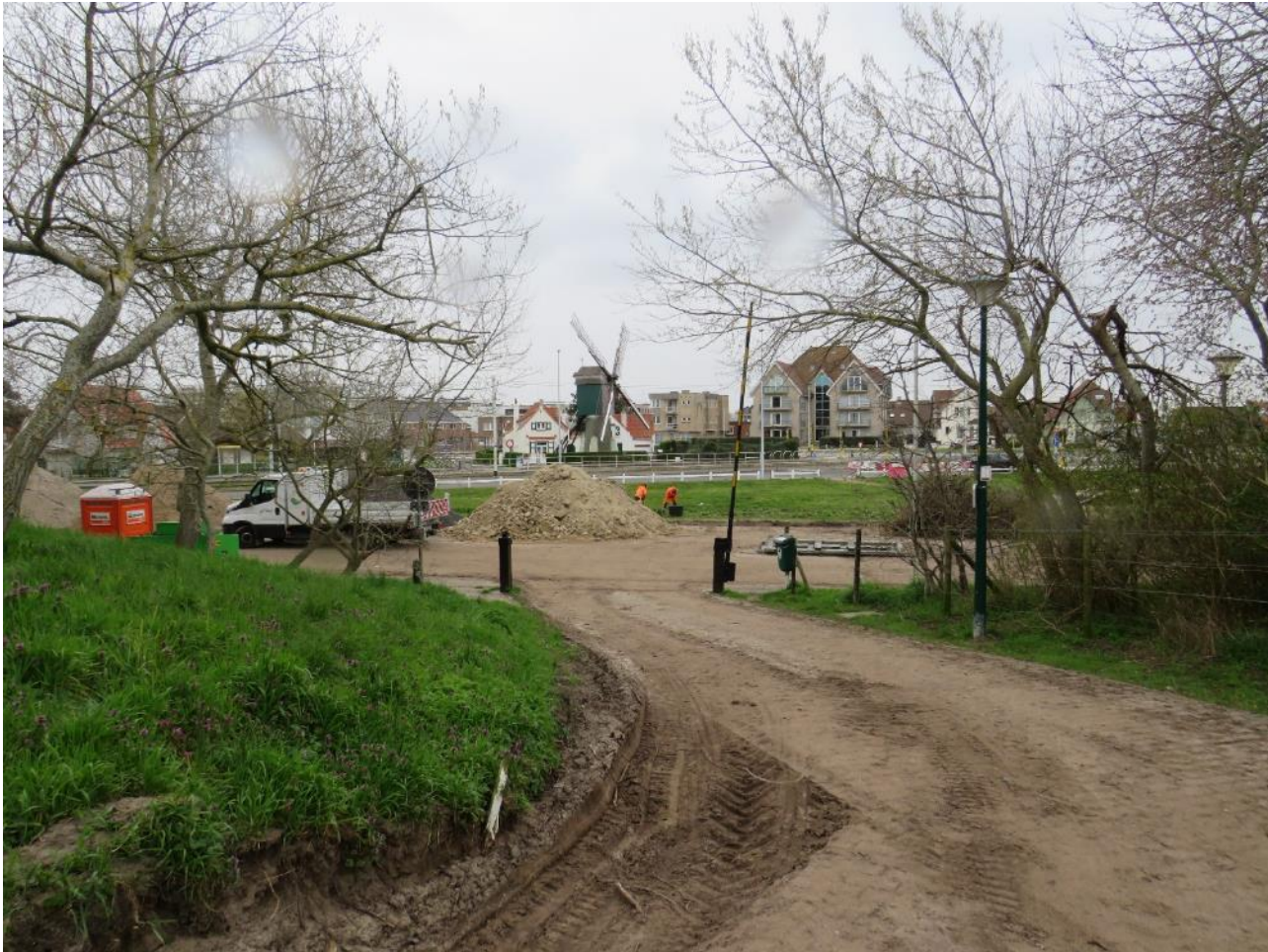
Foto 15 - Zicht op de Hubertmolen vanuit het noordwesten.
